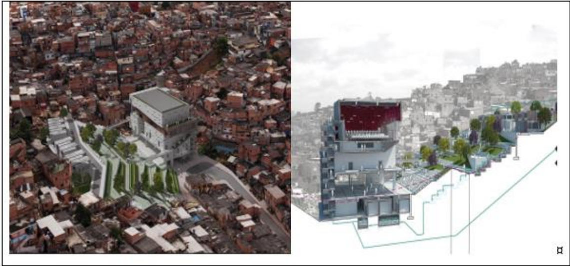
Figura 1 Centro de Infraestructura Cívica y Remediación urbana, São Paulo, Brasil
