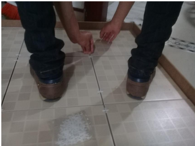
Figura 25: Colocación distanciadores. Elaboración propia.
