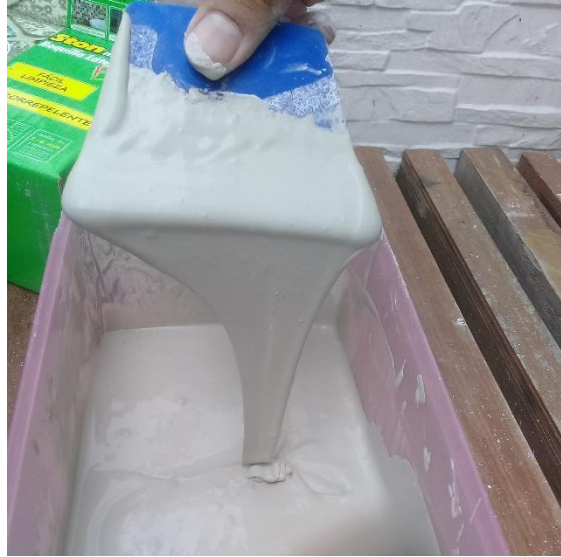
Figura 26: Preparación boquilla. Elaboración propia.
