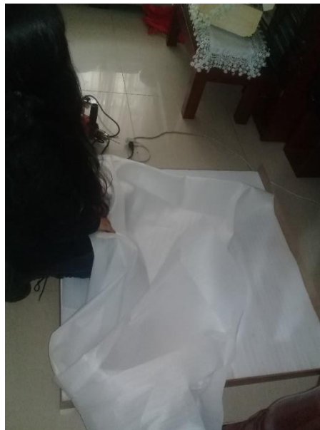
Figura 21: Colocación Yumbolon. Elaboración propia.
