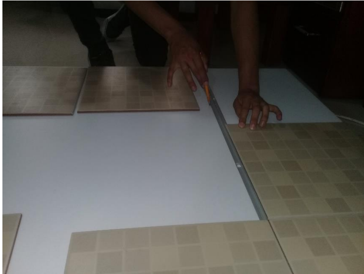
Figura 18: Colocación previa del perfil. Elaboración propia.
