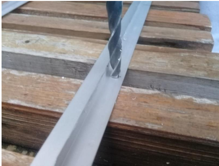
Figura 16: Perforación perfil. Elaboración propia.
