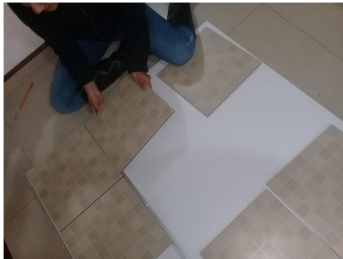
Figura 17: Replanteo Baldosas. Elaboración propia.
