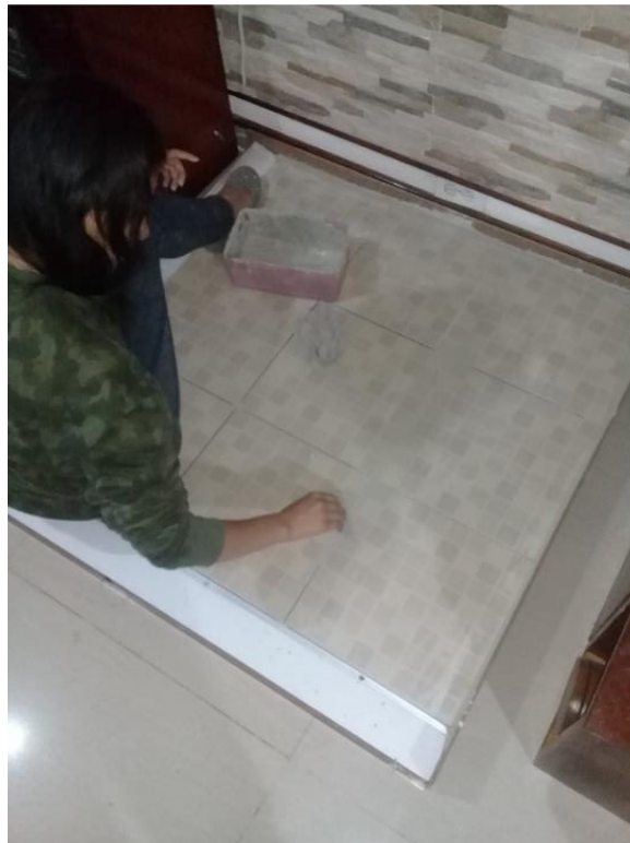
Figura 27: Colocación boquilla entre baldosas. Elaboración propia.
