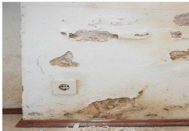
Figura 9 Representación de humedad por capilaridad
