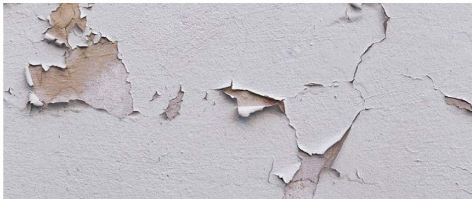
Figura 5 Representación de descascaramiento
