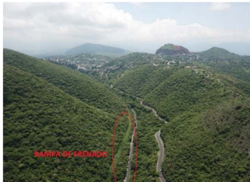
Rampas de frenado en la carretera Cuernavaca – Cuatlixco
