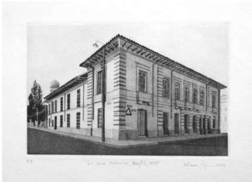
Figura 9. Casa Botánica. Sede del Museo Nacional de Colombia tras su apertura al público en 1824. La edificación fue demolida en la década de 1950. Fuente: Espinosa, A. (s.f) Grabados. Tomado de: https://bit.ly/2PAXO2q
