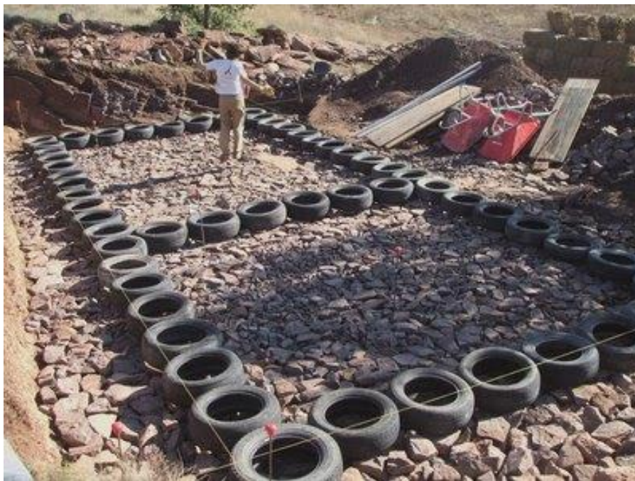
Ilustración 1. Uso de neumáticos en la construcción de la casa.
