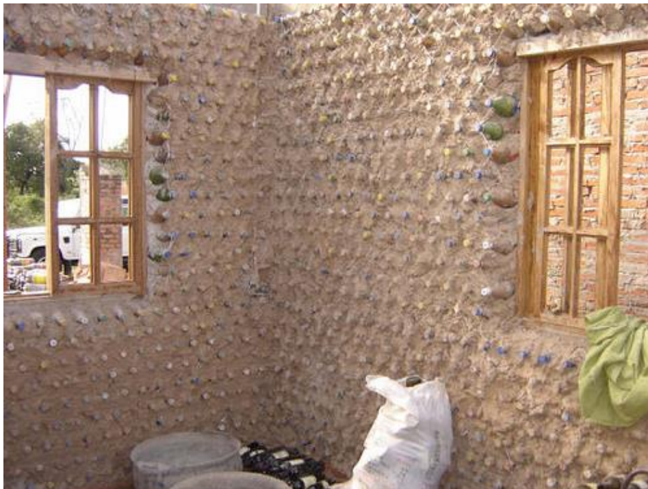
Ilustración 2. Muros con plástico reciclado
