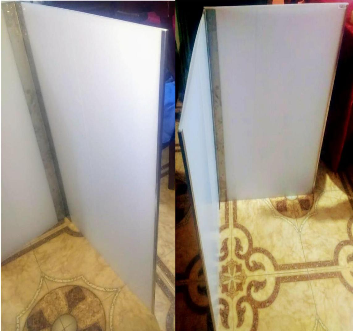
Ilustración 48 Detalle escala 1:1 unión esquinero
