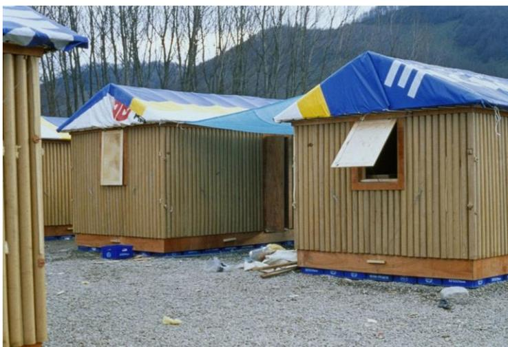
Ilustración 35 primer prototipo de una vivienda de emergencia en cartón
