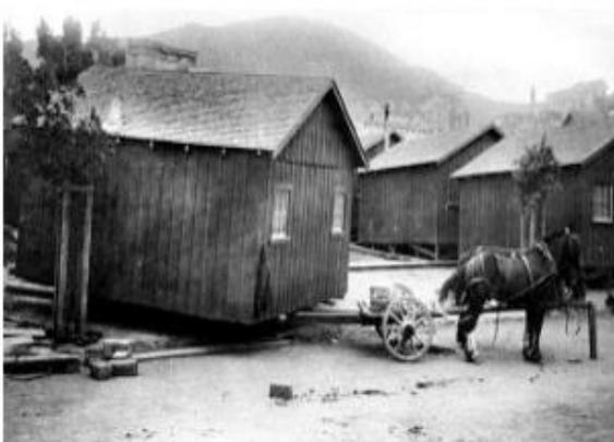
Ilustración 3 Transporte vivienda prefabricada en madera
