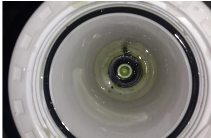
Figura 17. Carcasa de la membrana de carbón activada después de procesar el agua residual.
