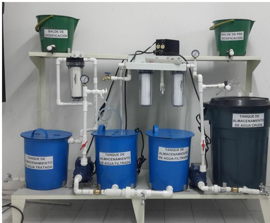
Figura 31. Planta piloto de membranas de filtración (nuevos cartuchos)
