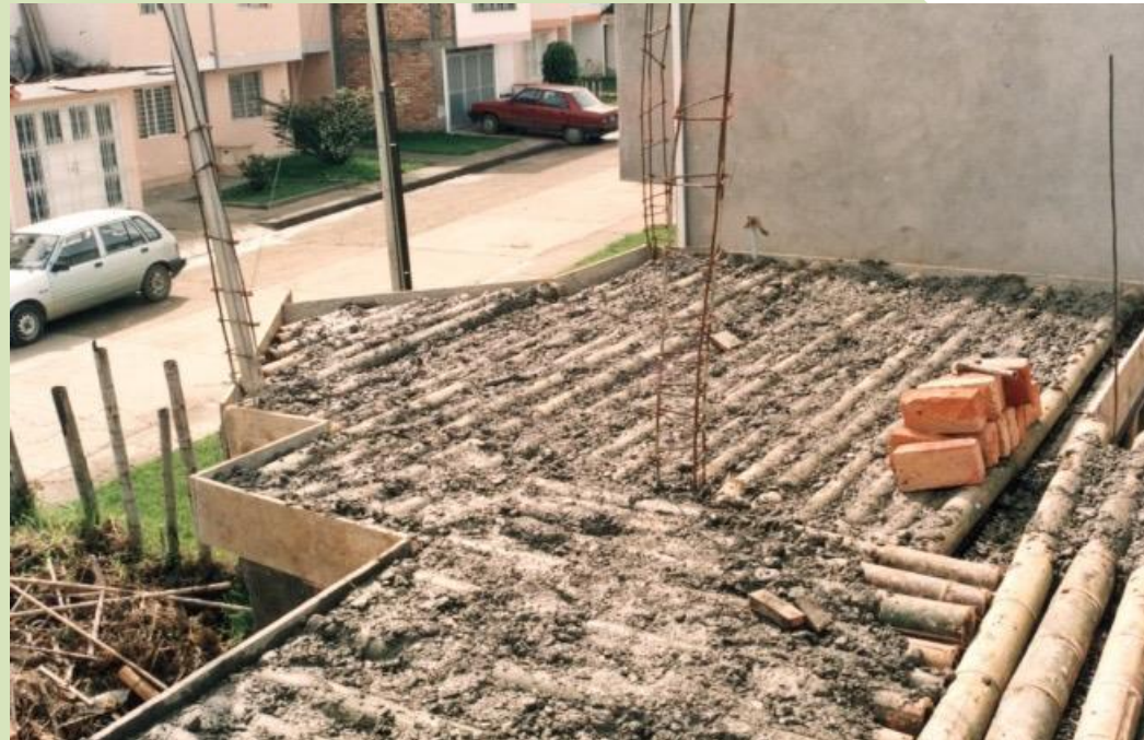
Concreto reforzado con bambú. Fuente: vivo arquitectura 2016.
