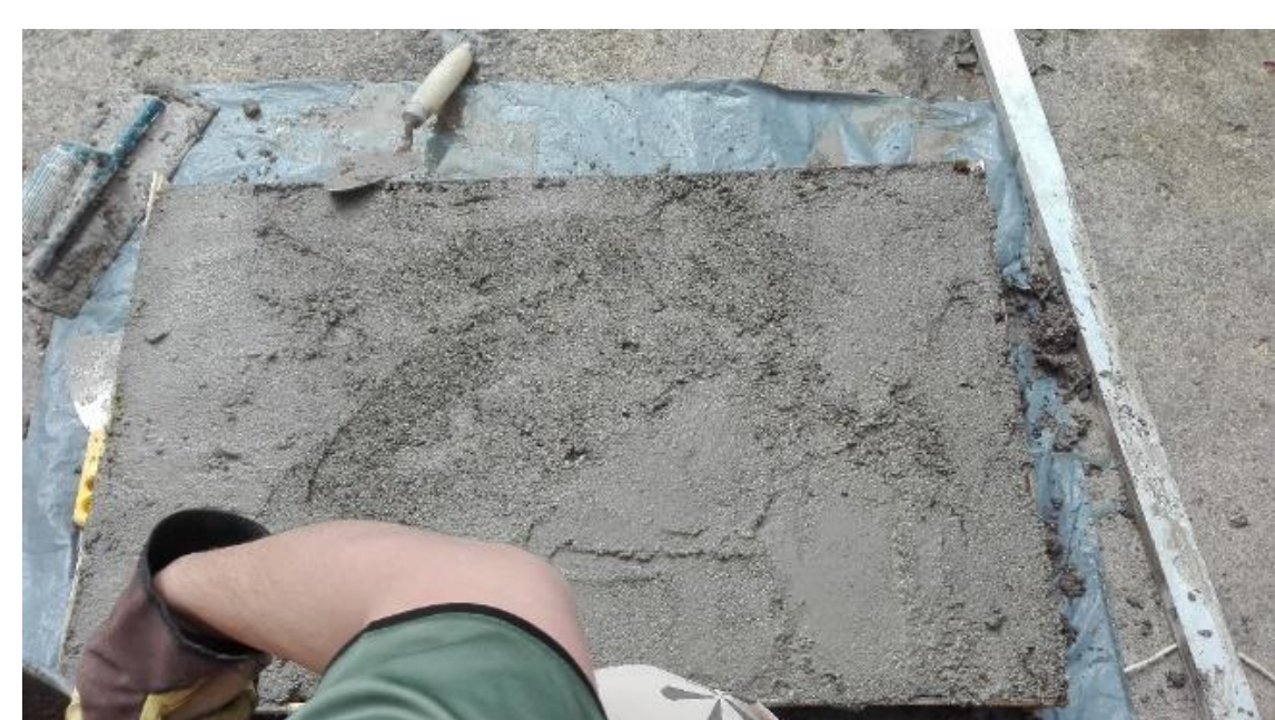
Fundición elemento Fuente: propia
