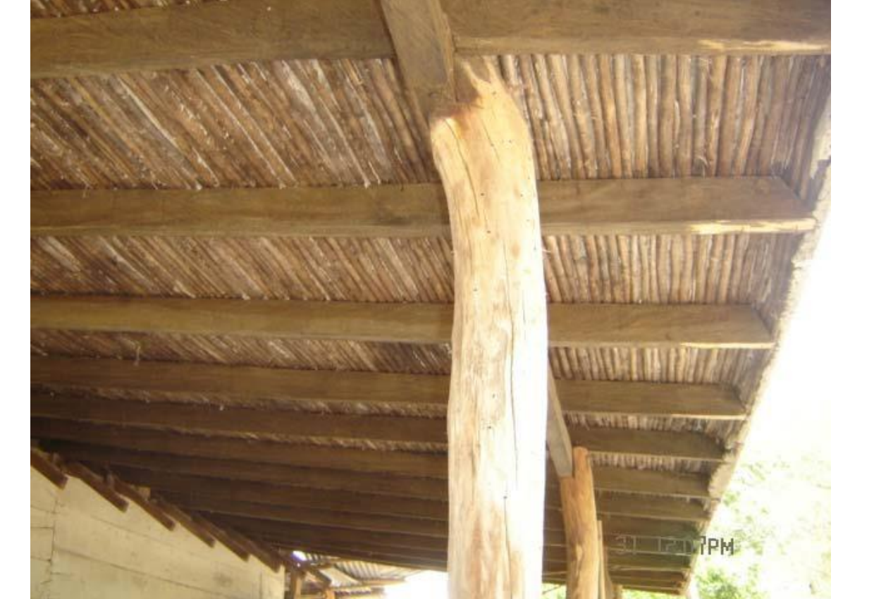
Base de la cubierta (varas de lata) en vista inferior. Fuente: González y Garzón 2008.
