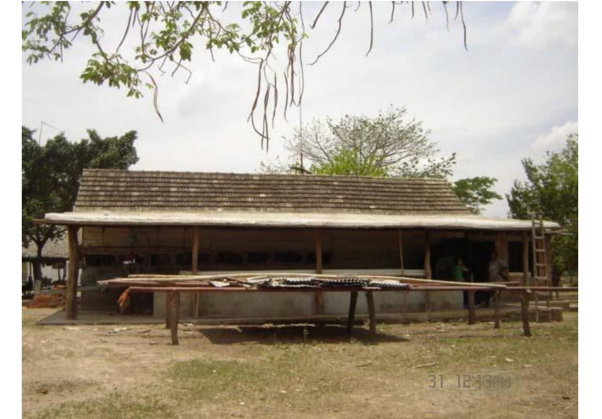
Vista general de cubierta Fuente: González y Garzón 2008.
