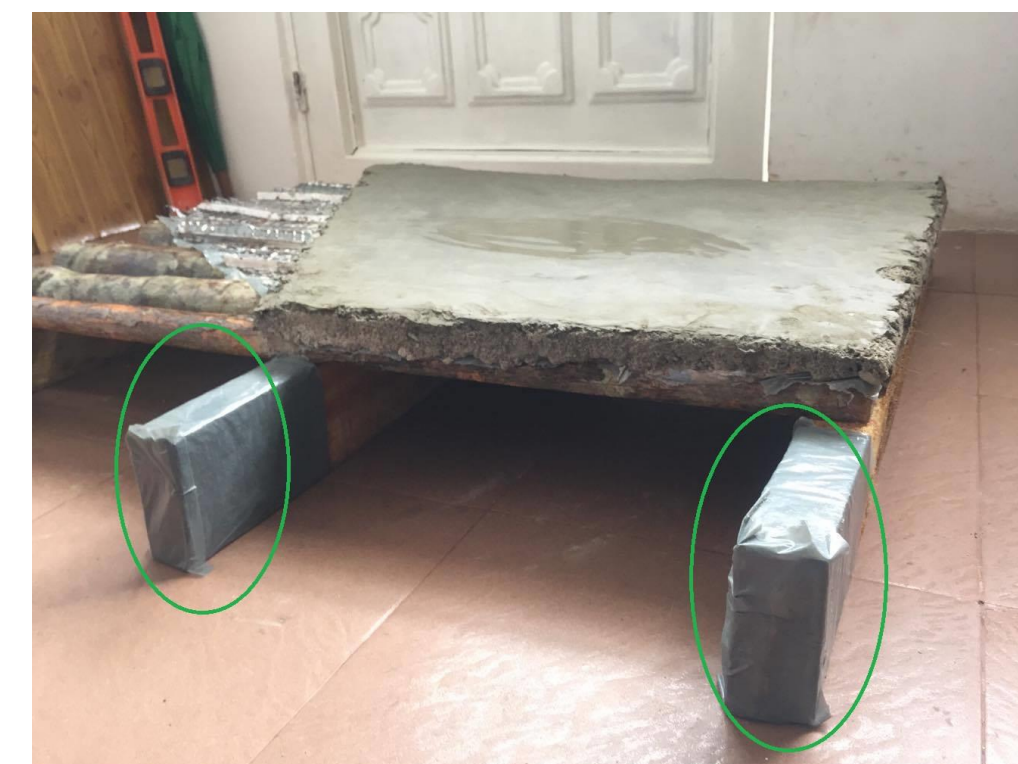
Aislamiento de humedad entrepiso en palma de lata. Fuente: propia.
