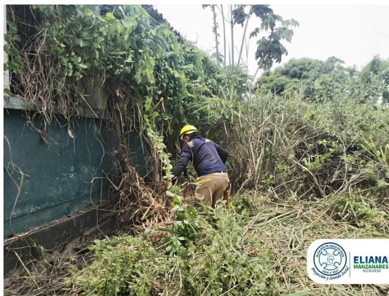
Figura 5 Estado actual del equipamiento.
