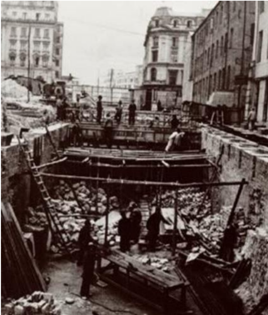
Ilustración 37 inicios de la canalización del río san francisco
