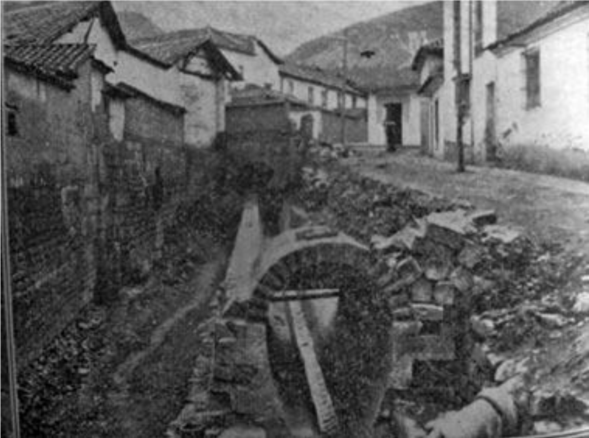
Ilustración 38 inicios de la canalización del río san francisco (2).
