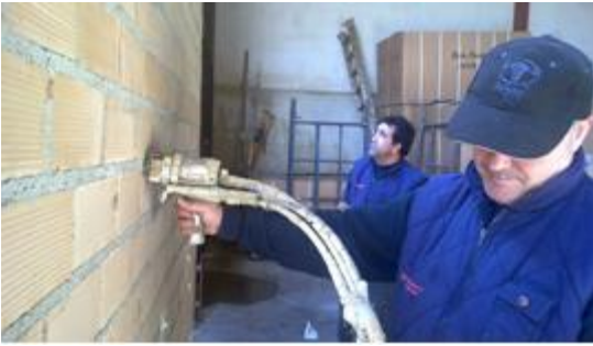
Imagen 4. Inyección del poliuretano con maquinaria
