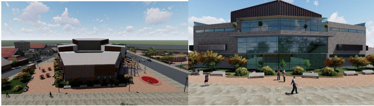
Figura 48. Fachada Este y Oeste.
