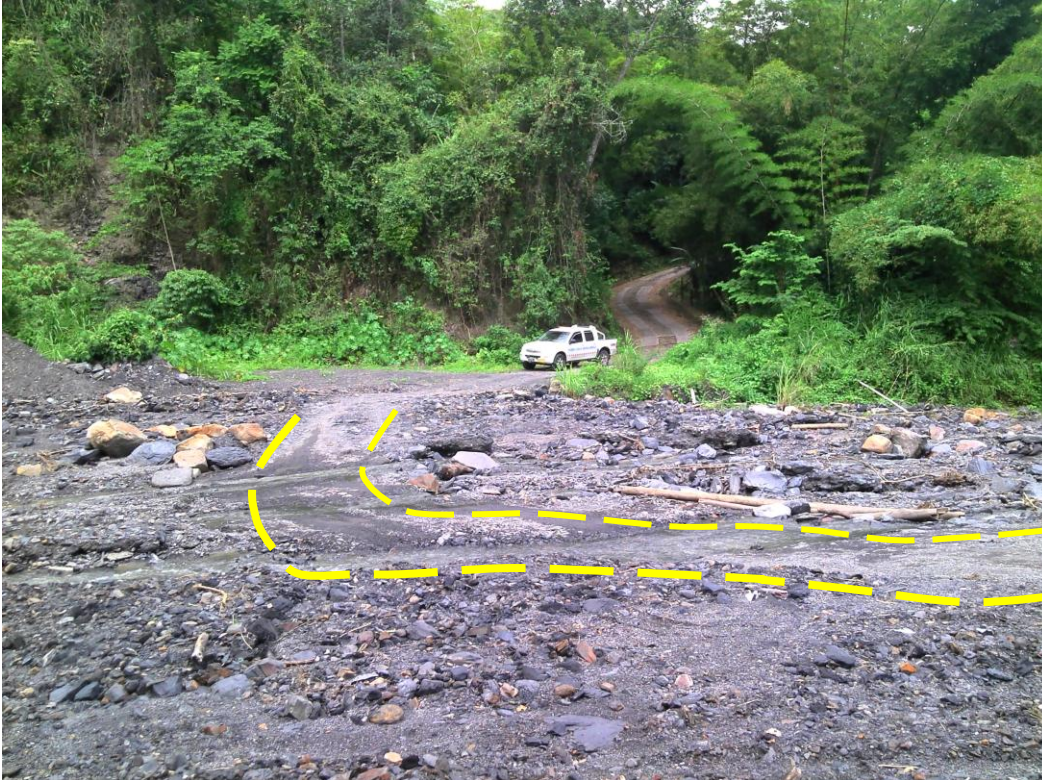
Fotografía 1. Tramo vial que atraviesa el cauce sin superficie de rodadura. El tramo anterior cuenta con superficie tipo placa huella.
