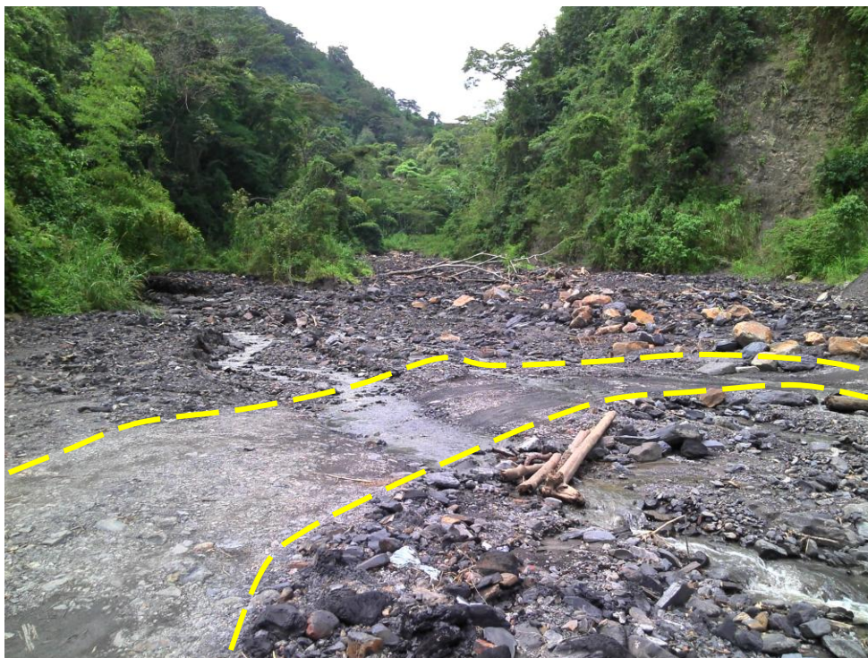
Fotografía 2. Afirmado pobre en material in situ del afluente, el cual aporta un superficie mínima de tránsito, moderada para vehículos 4x4 o doble tracción. Nótese el cruce de agua de forma ortogonal al eje del tramo vehicular.
