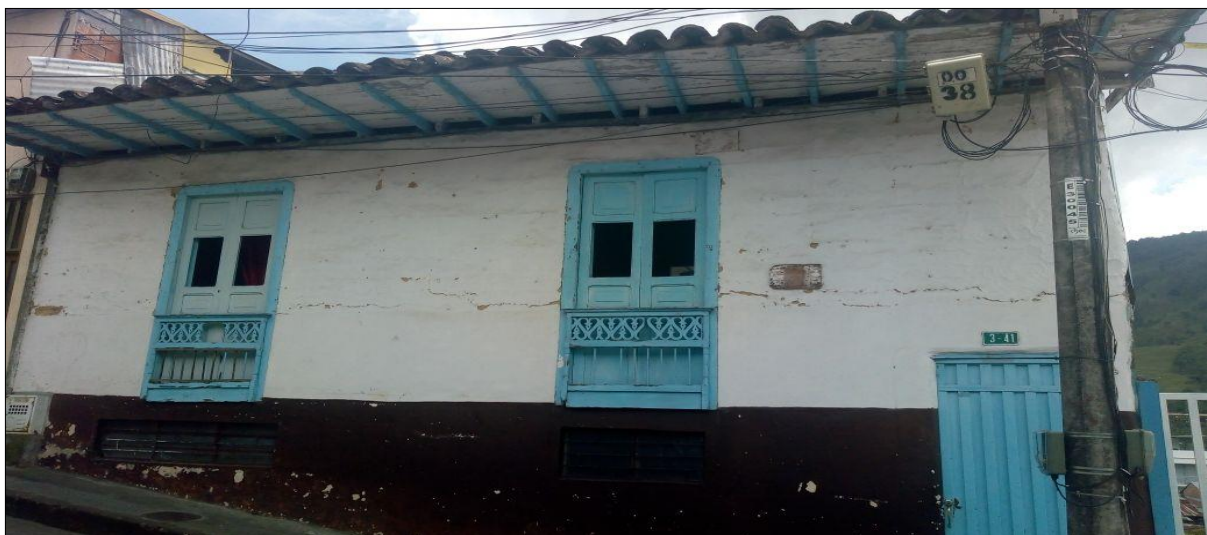
[Figura 12] Fachada frontal Casa de Alberto Giraldo.
