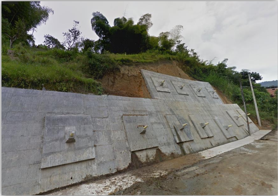
[Figura 20] Elaboración Propia. (octubre 2018) Muro de contención Cárcel.
