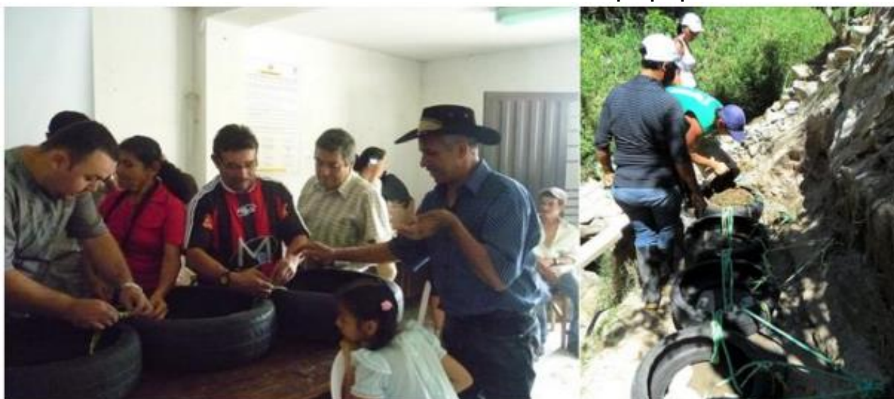
Ilustración 32 Amarre entre llantas con manila de polipropileno
