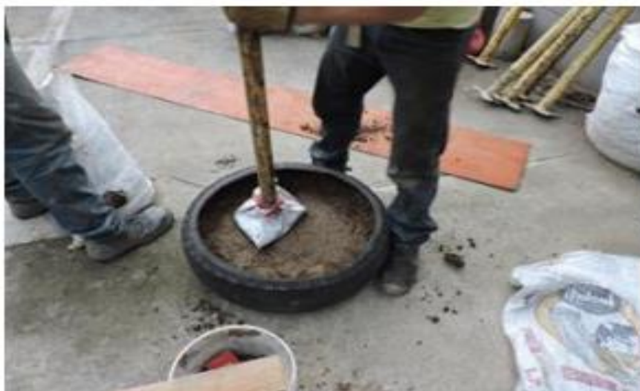
Ilustración 30 Llenado manual y mecánico de las llantas de desecho
