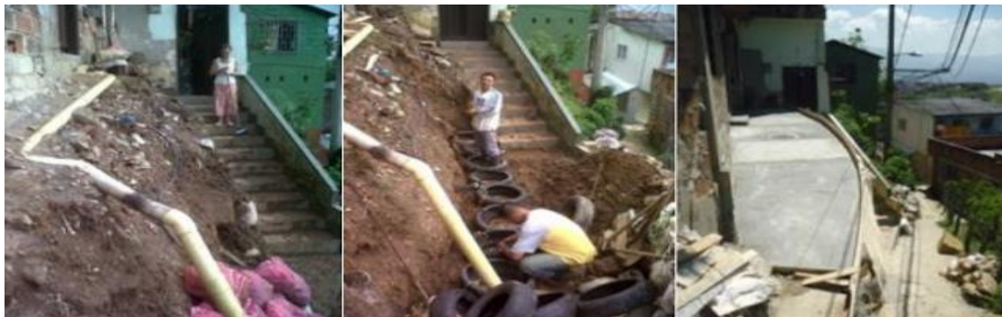
Ilustración 1 Obra para la mitigación de evento de inestabilidad barrió la Fuente Clara
