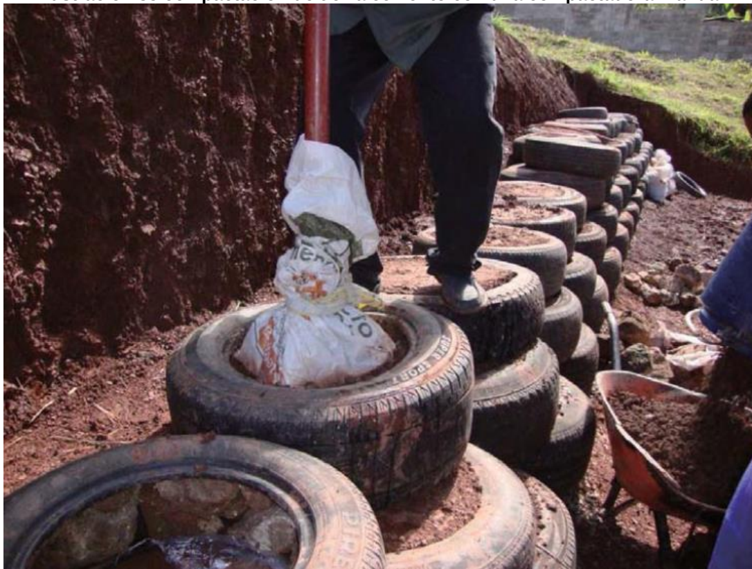
Ilustración 35 compactación de tierra cemento con una compactadora manual
