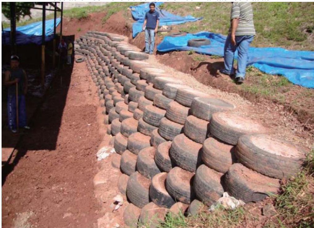
Ilustración 38 muro de contención con llantas recicladas
