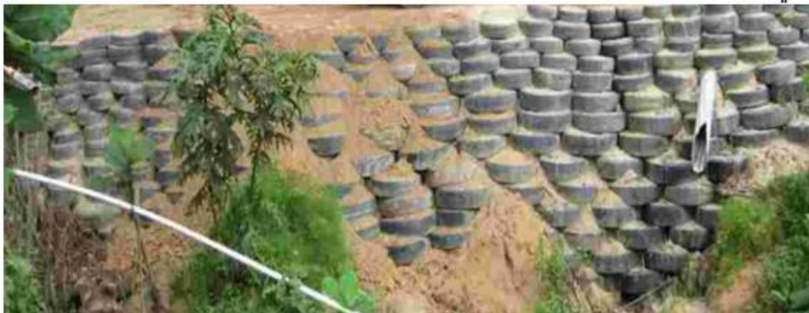
Ilustración 5 muro de contención final con la utilización de neumáticos reciclados
