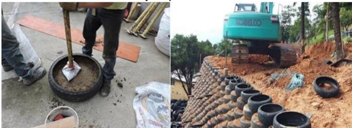
Ilustración 4 llenado y compactado del material de relleno
