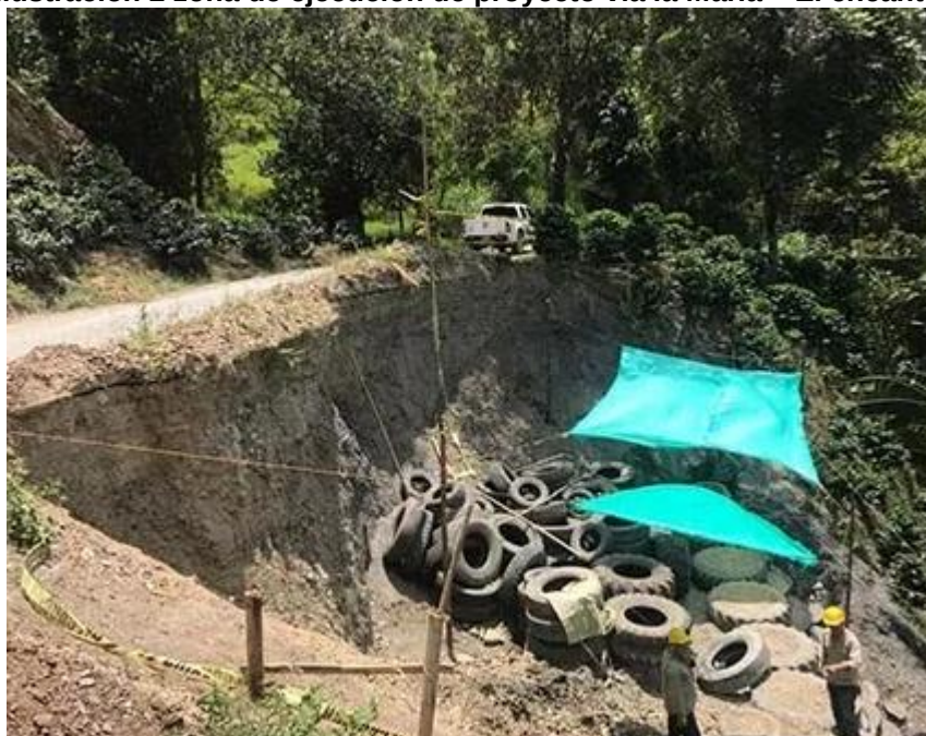
Ilustración 2 zona de ejecución de proyecto vía la María – El encanto.
