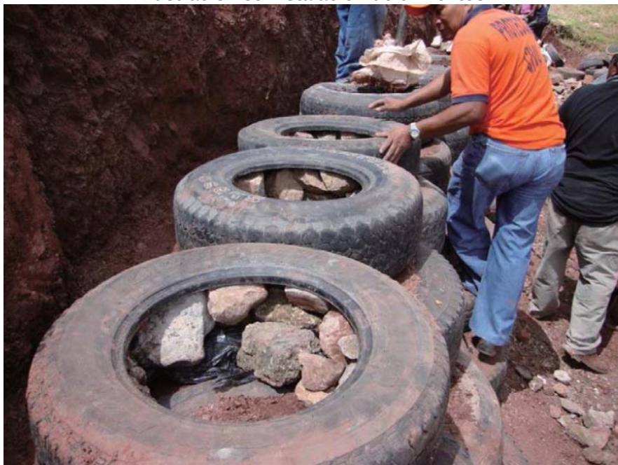
Ilustración 33 instalación de cimientos
