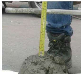
Figura 12. Medida de asentamiento de pasta de concreto.
