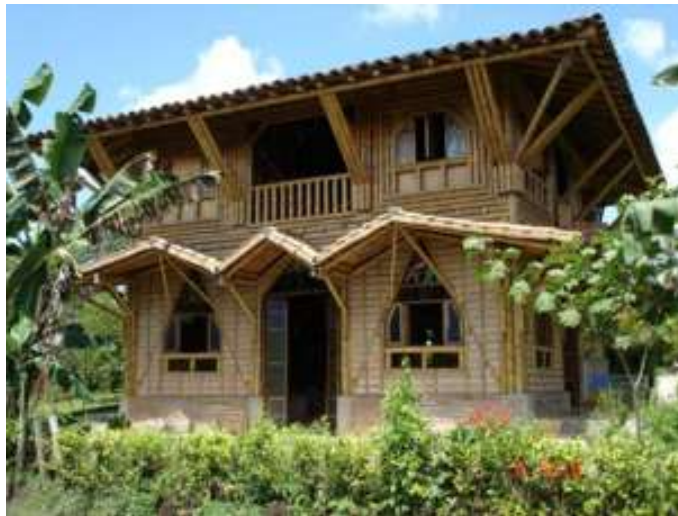
Figura 2. Construcciones en guadua
