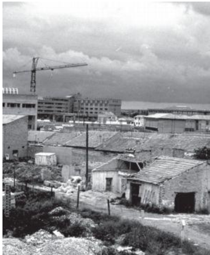
Barrió Belén década de los 50° foto tomada de google
