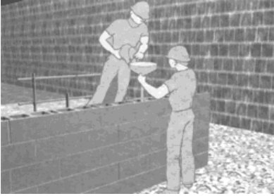
Figura 26. Inyección concreto con embudo
