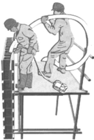
Figura 25. Inyección de concreto entre celdas con bomba
