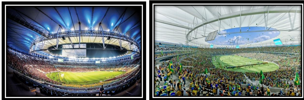
Figura 6: Interior estadio Maracanã, circulaciones y gradas
