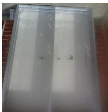
Ilustración 15. Se instala la lámina de 4 mm de Superboard Fuente: Elaboración propia (2016)
