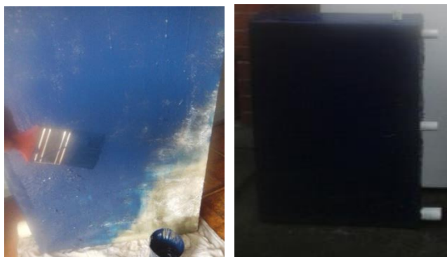
Ilustración 16. Se le dá un acabado a los tanques con pintura azul oscuro. Fuente: Elaboración propia (2016)
