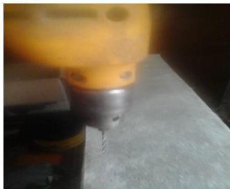
Ilustración 10. Perforación sobre las láminas de fibrocemento con broca de 3mm. Fuente: Elaboración propia (2016)
