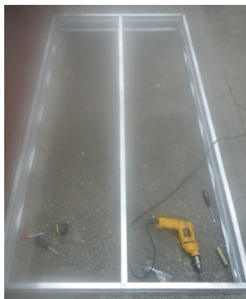
Ilustración 14. Se arma la perfilería base 6 y base 9 de manera independiente y posteriormente se ensamblan las dos Fuente: Elaboración propia (2016)
