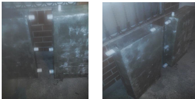
Ilustración 13. Ensamblaje de los tanques e instalación de accesorios. Fuente: Elaboración propia (2016)
