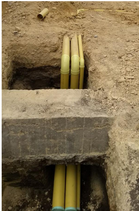
Ilustración 17; Instalaciones sanitarias en cimentación. Fuente: Propia; Cimentación Obra estrato 2 (2017).
