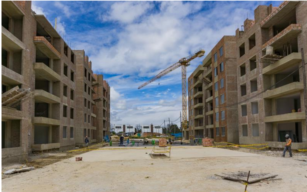
Ilustración 24, Obra estrato 5 Fuente: Propia (2017)
