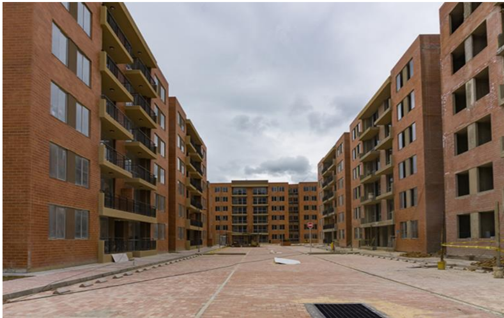
Ilustración 23, Obra Estrato 3. Fuente: Propia (2017)
