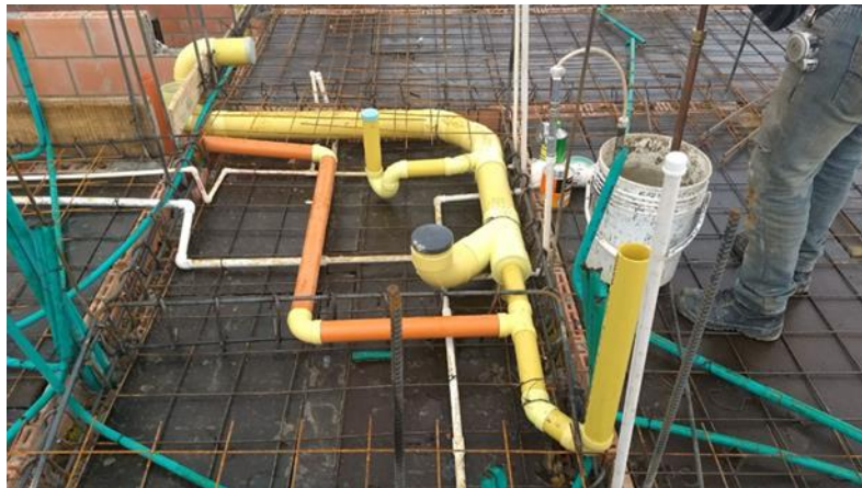
Ilustración 20; Tubería Embebida en Placa de Concreto. Fuente: Propia (2017)
