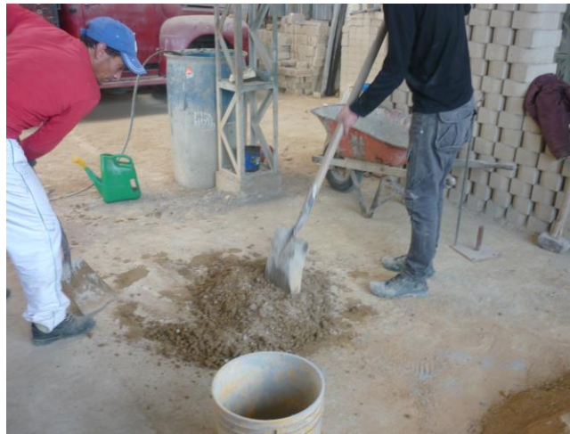
Ilustración 4. Mezcla de los materiales. Fuente propia.
