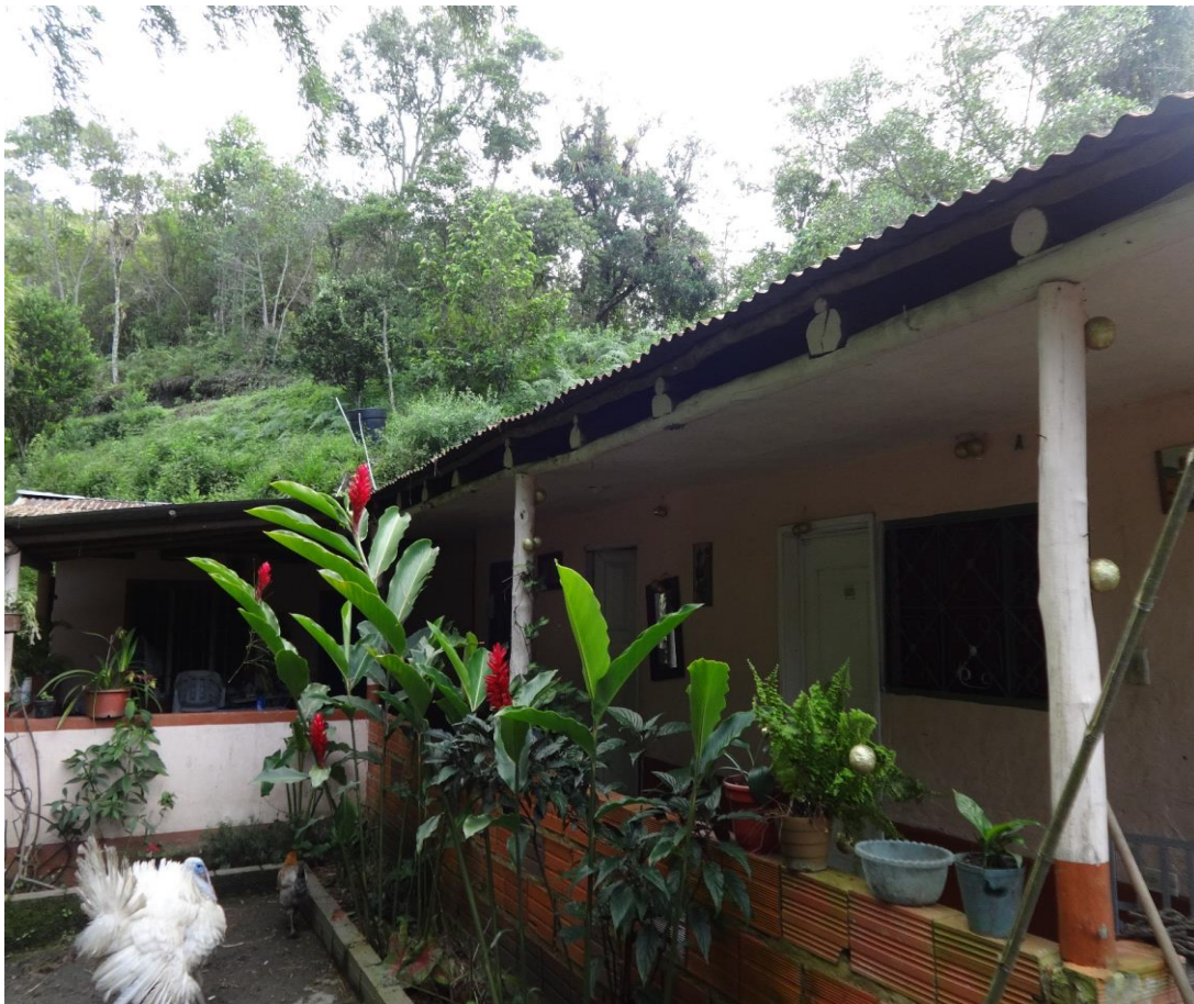
Ilustración 37. Análisis vivienda#3. Cuya técnica es adobe y esterilla de guadua para la cubierta.
