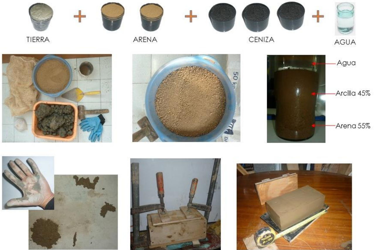
Ilustración 19. - Proceso constructivo de bloque con tierra (T2). Fuente Propia.
