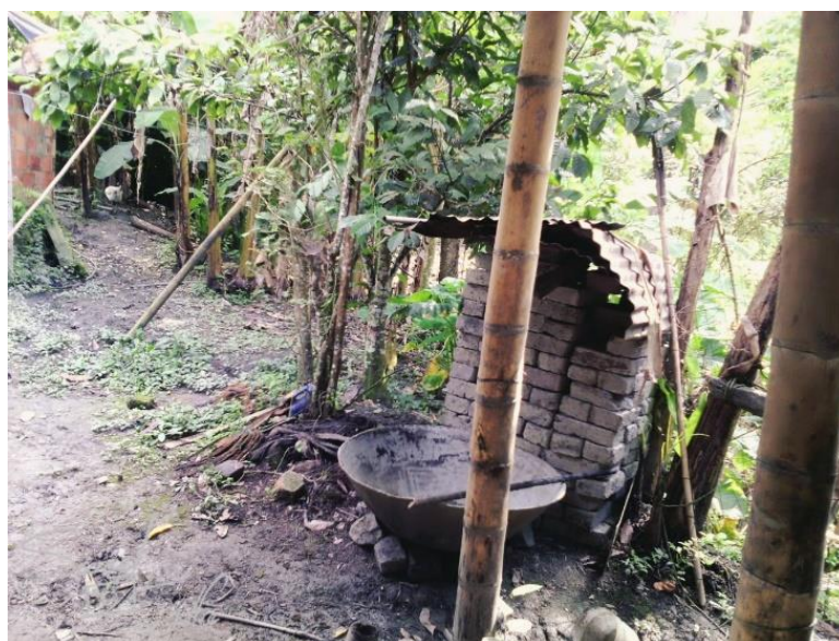
Ilustración 35. Adobes originales para mantenimiento de la vivienda. Fuente propia.
