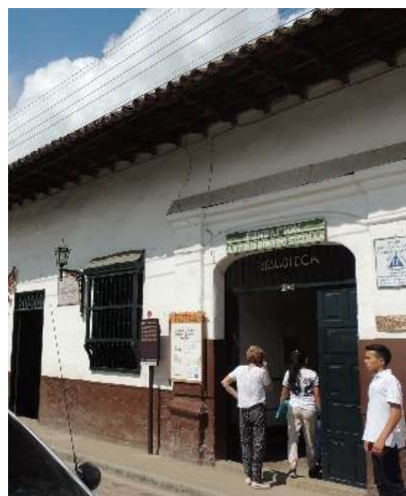
Ilustración 9 Casa de los Virreyes (Fuente propia)
