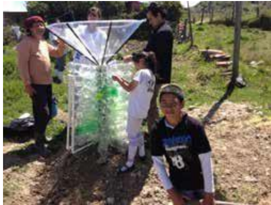
Figura 10. Instalación del sistema octo.
