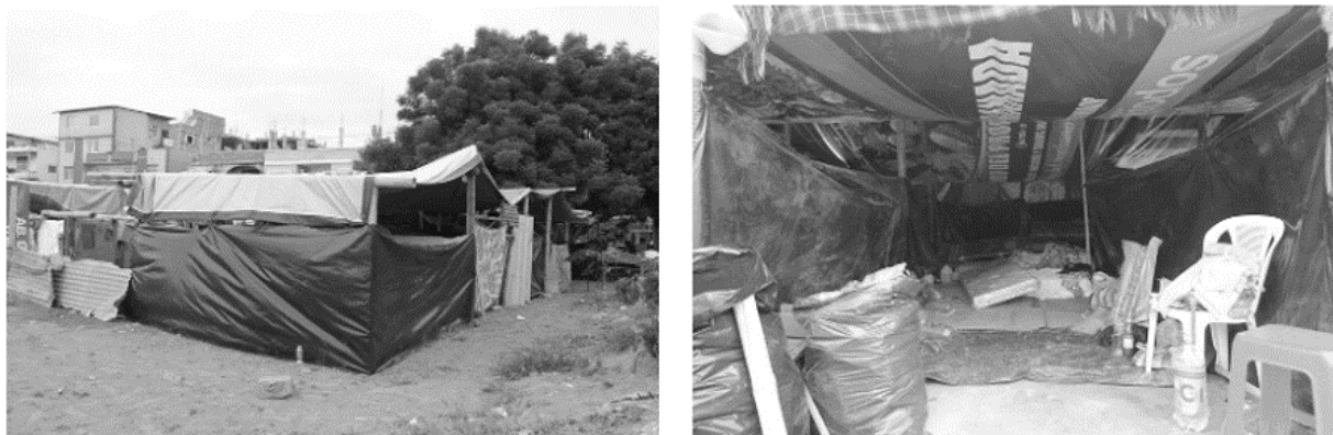
Figura 12 Vivienda de Autoconstrucción
