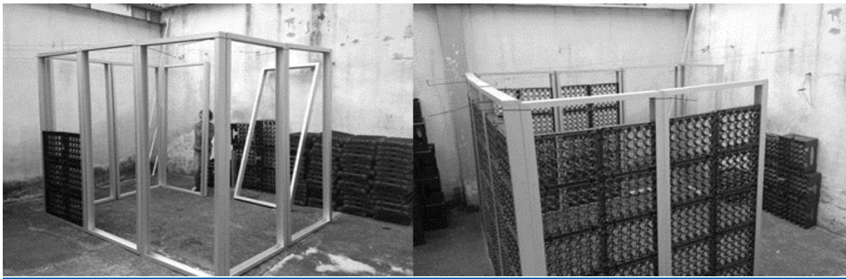
Figura 11 Muros en canastas de cerveza
