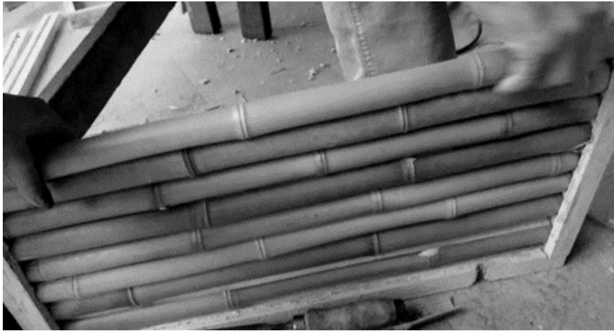
Figura 24. Montaje de bambú aulonemia con el marco, ajustando a conicidad. Elaboración propia.
