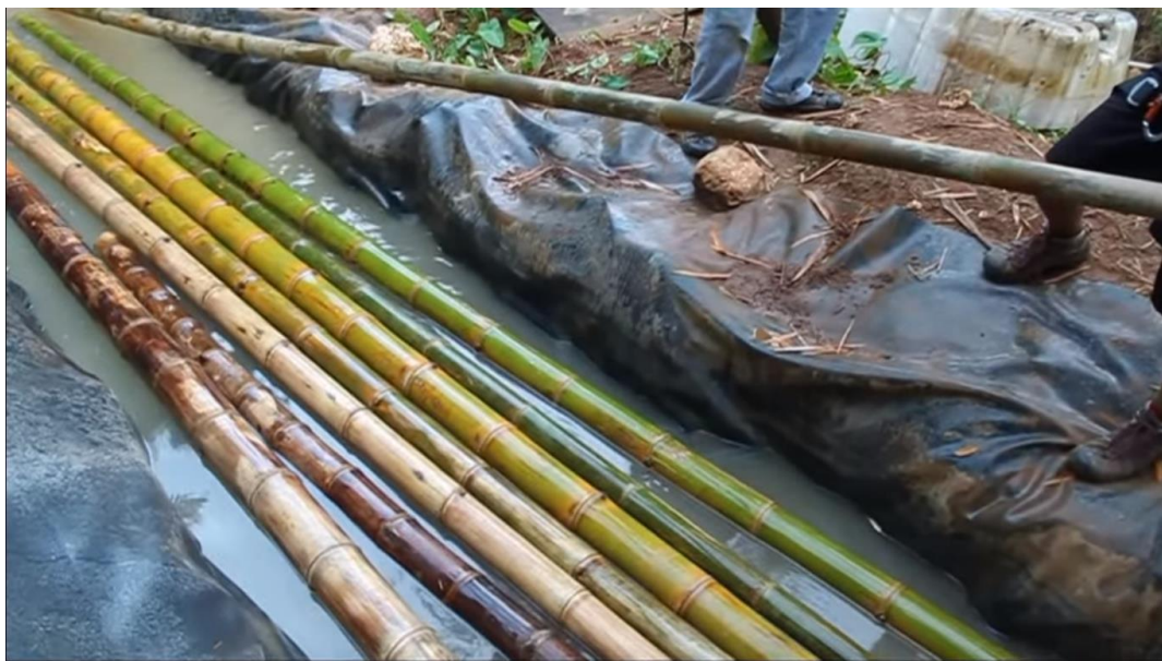
Figura 1. Guadua en inmunización. Fuente: Manuel, J. (2007) Guadua- Taller en Puerto Rico- 2010 - Parte 1
