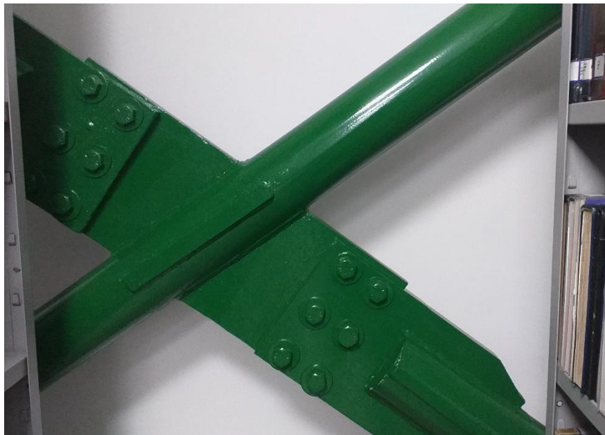
Figura 3. Arriostramiento en metal de la biblioteca de la Universidad la gran Colombia. Fuente: Elaboración propia.
