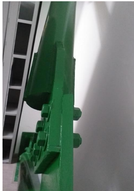
Figura 4. Arriostramiento en metal de la biblioteca de la Universidad la gran Colombia. Fuente: Elaboración propia.
