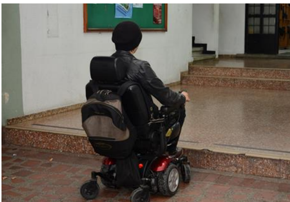
Figura 17. Barreras por derribar.
