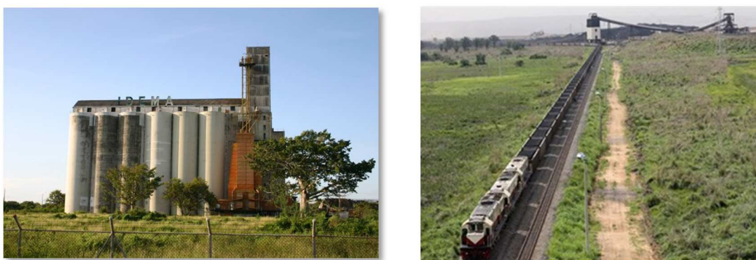
Ilustración 4 operación férrea Bodega Idema
