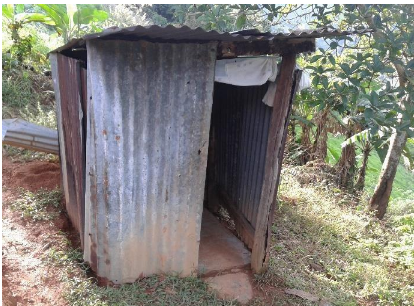
Figura 6 Baño - Vivienda rural ubicada en Chaparral, Tolima.
