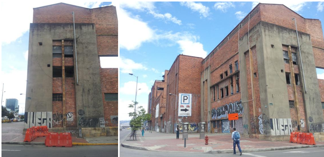
Figura 9 y 10: Materialidad de la construcción en Fachadas. Fuente: Propias
