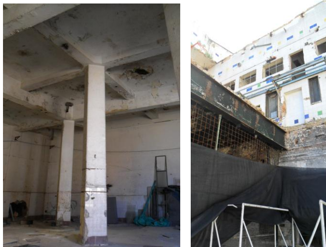
Figura 17 y 18: Estado actual al interior de las edificaciones Fuente: Propias
