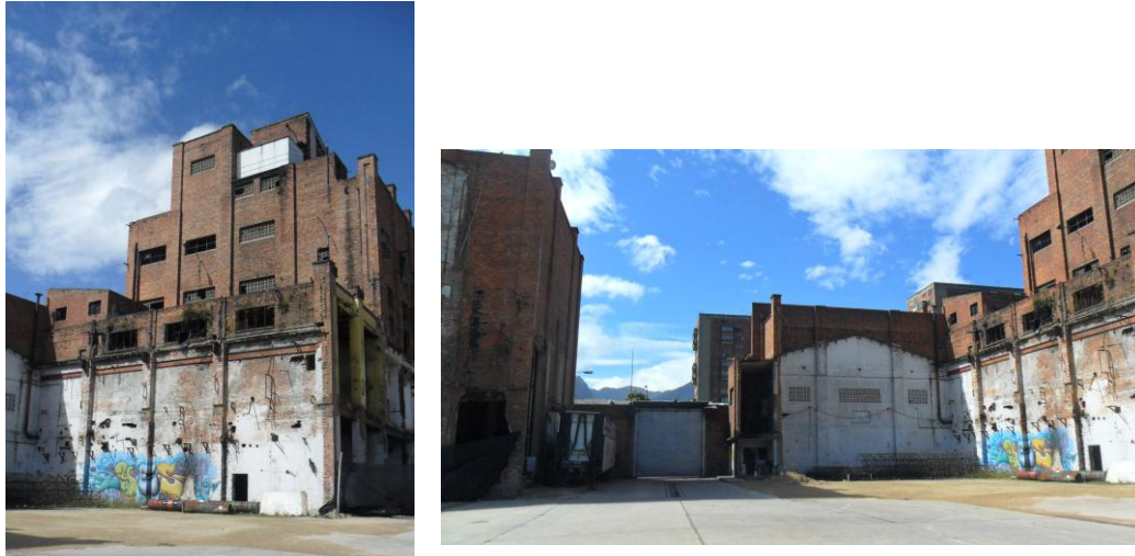
Figura 15 y 16. Estado actual al interior de las edificaciones Fuente: Propias
