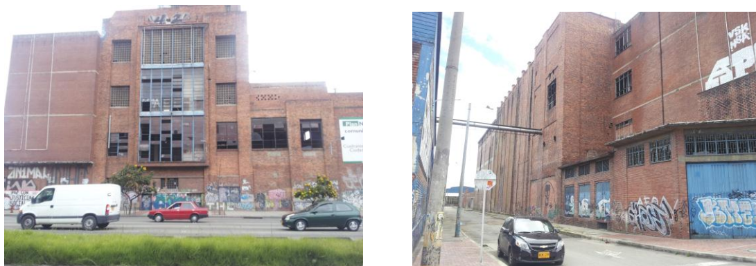
Figura 11 y 12: Materialidad de la edificación de Patrimonio Fuente: Propias
