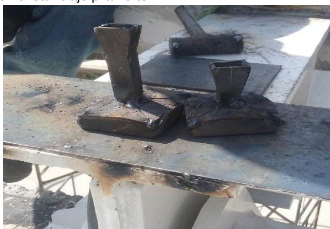
Figura 50. Terminación ensamblaje pila norte
