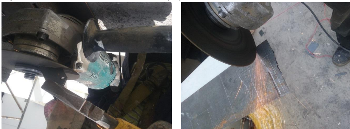
Figura 47. Corte de sección frontal elemento tipo pila.
