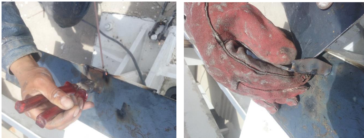
Figura 48. Ensamble estructura pila
