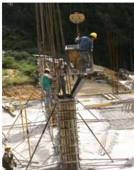
Figura 29. Falta de elementos de protección y de hojas de vida de los andamios tubulares.
