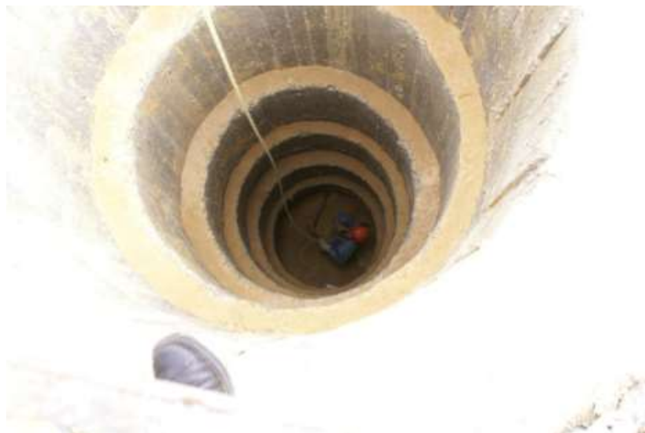
Figura 24. Utilización de elementos de protección en los caisson.
