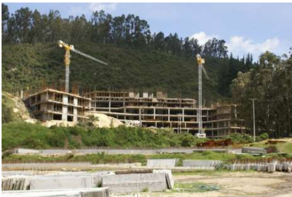
Figura 22. Torre Grúa. Fuente: Propia
