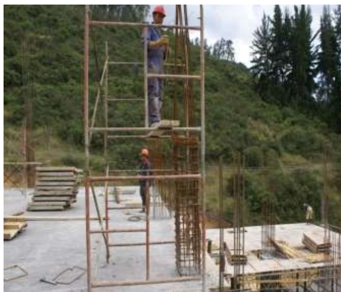
Figura 29. Falta de elementos de protección y de hojas de vida de los andamios tubulares.
