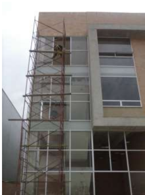
Figura 33. Supervisión de los sistemas temporales.
