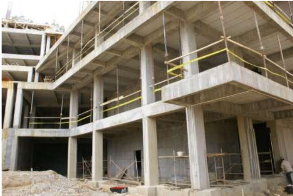
Figura 26. Señalización cinta reflectiva.
