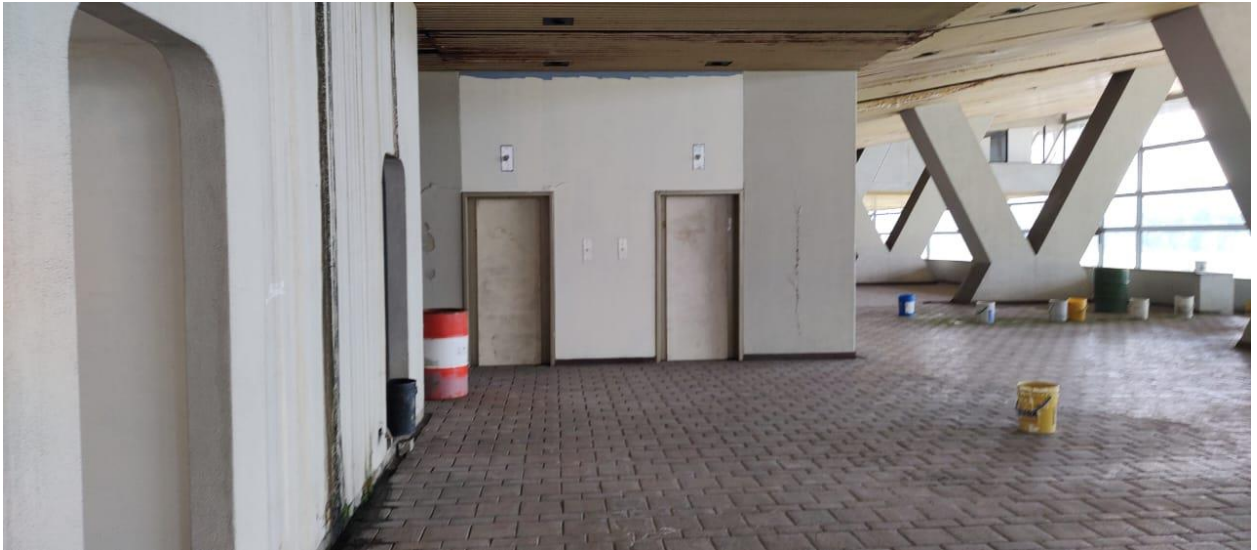
Figura 20. Imagen del Estado de la Edificación Existente para el año 2024
