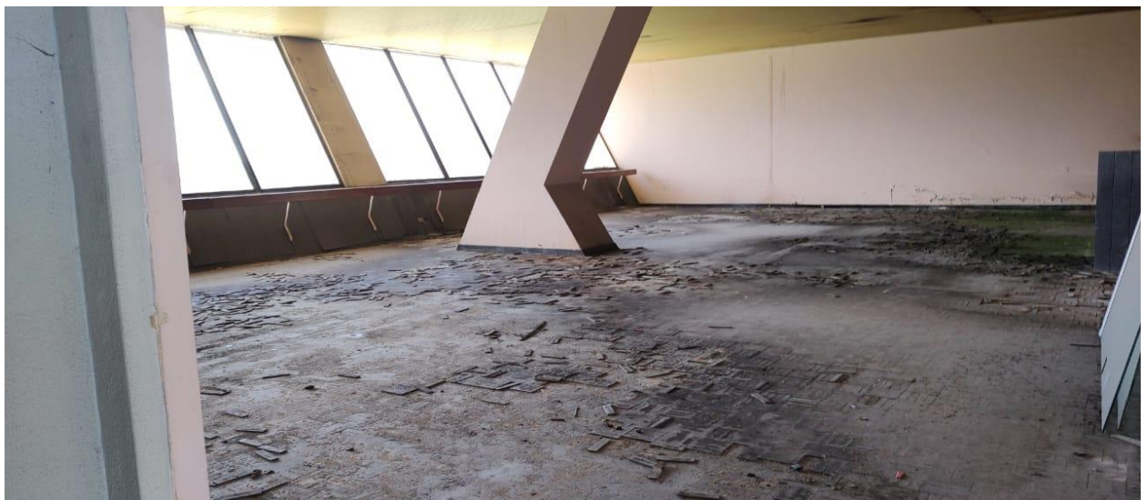
Figura 17. Imagen del Estado de la Edificación Existente para el año 2024
