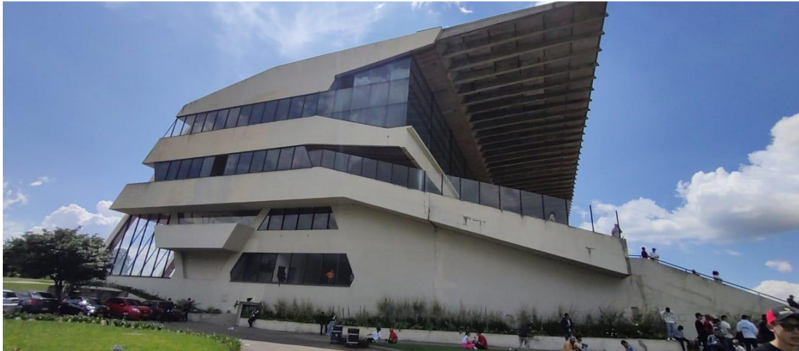
Figura 6. Imagen del Estado de la Edificación Existente para el año 2024
