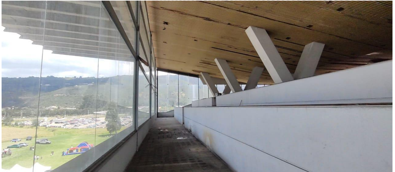
Figura 12. Imagen del Estado de la Edificación Existente para el año 2024
