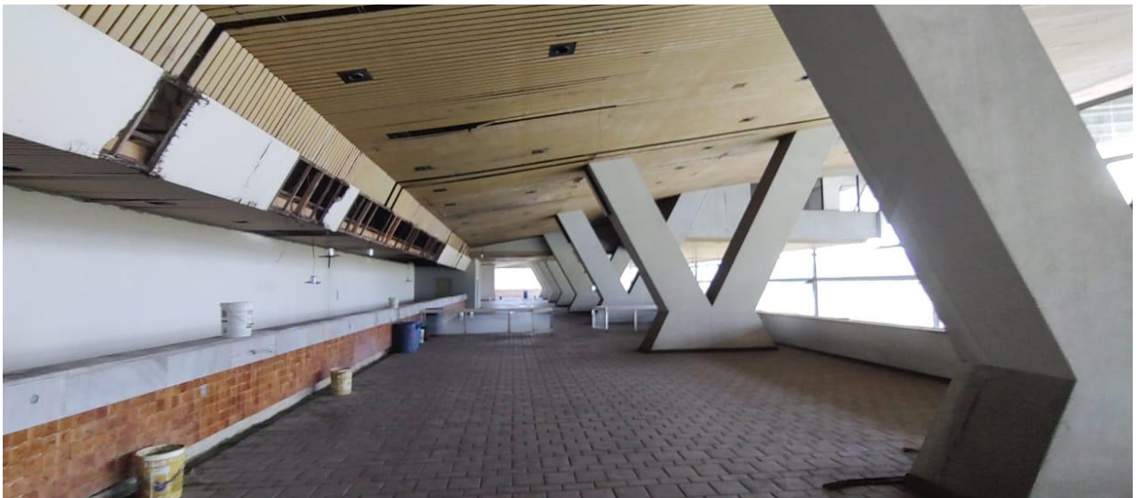
Figura 14. Imagen del Estado de la Edificación Existente para el año 2024
