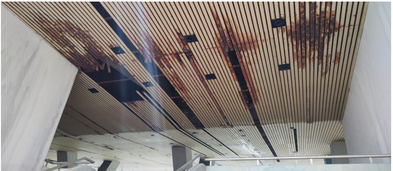
Figura 21. Imagen del Estado de la Edificación Existente para el año 2024
