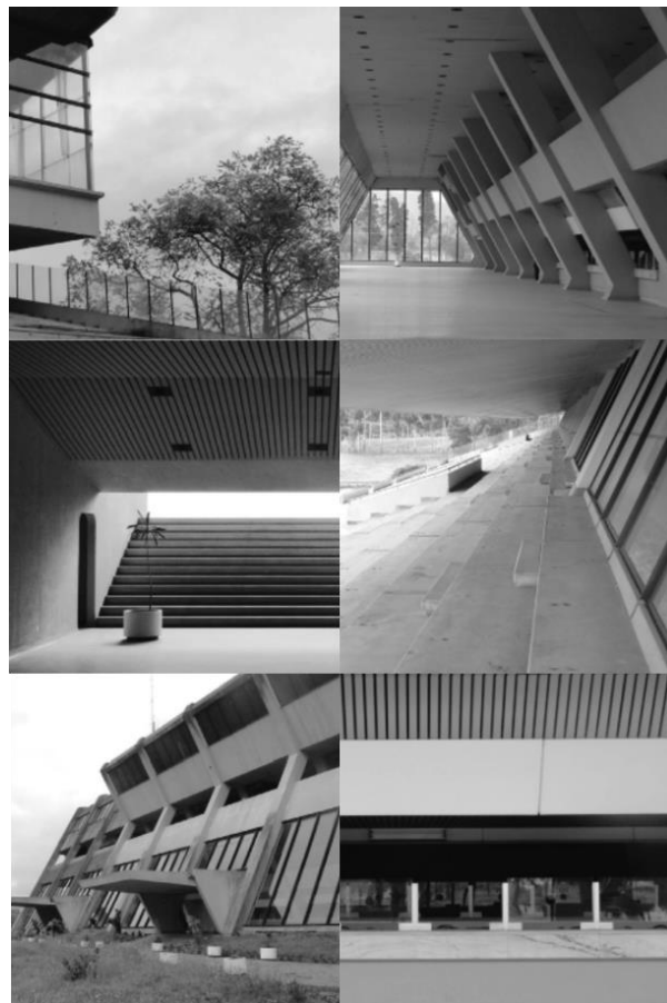
Figura 4. Imágenes del Estado de la Edificación Existente para el año 2015 exteriores
