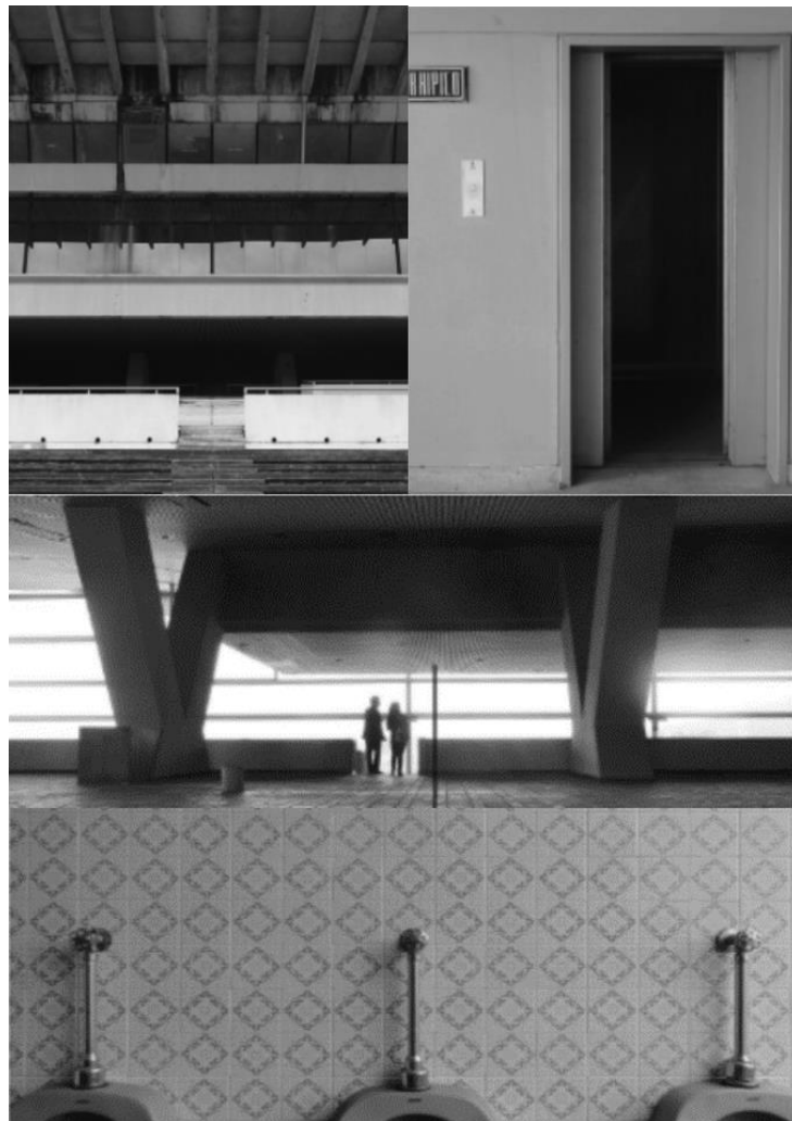
Figura 5. Imágenes del Estado de la Edificación Existente para el año 2015 interiores
