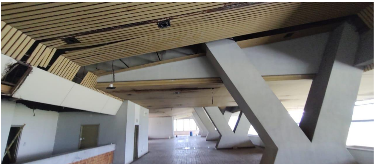
Figura 11. Imagen del Estado de la Edificación Existente para el año 2024
