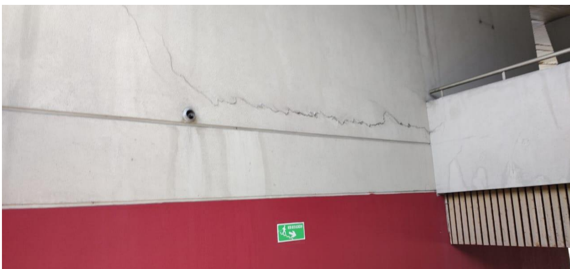
Figura 9. Imagen del Estado de la Edificación Existente para el año 2024
