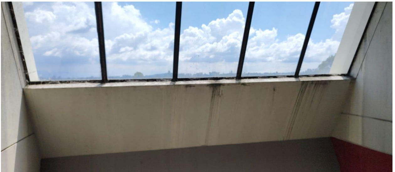
Figura 10. Imagen del Estado de la Edificación Existente para el año 2024
