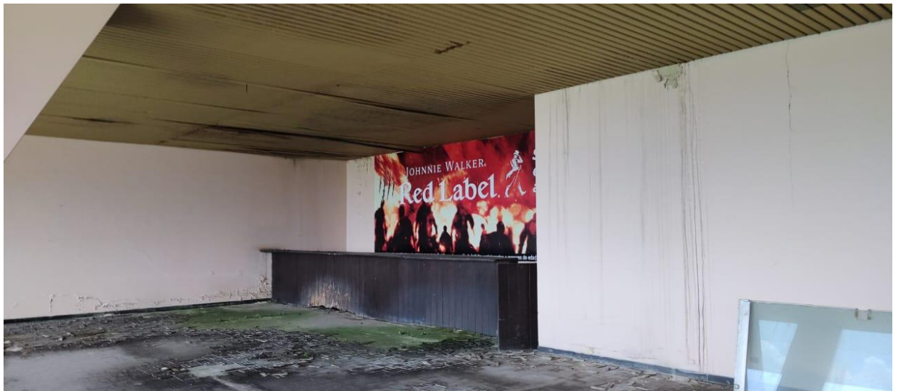
Figura 16. Imagen del Estado de la Edificación Existente para el año 2024
