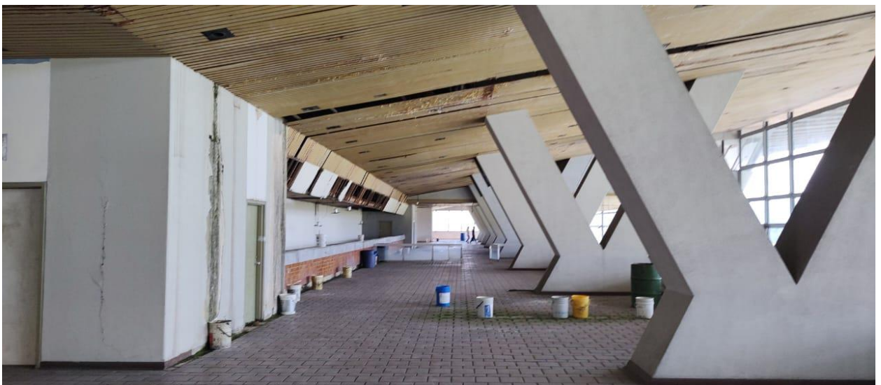
Figura 19. Imagen del Estado de la Edificación Existente para el año 2024
