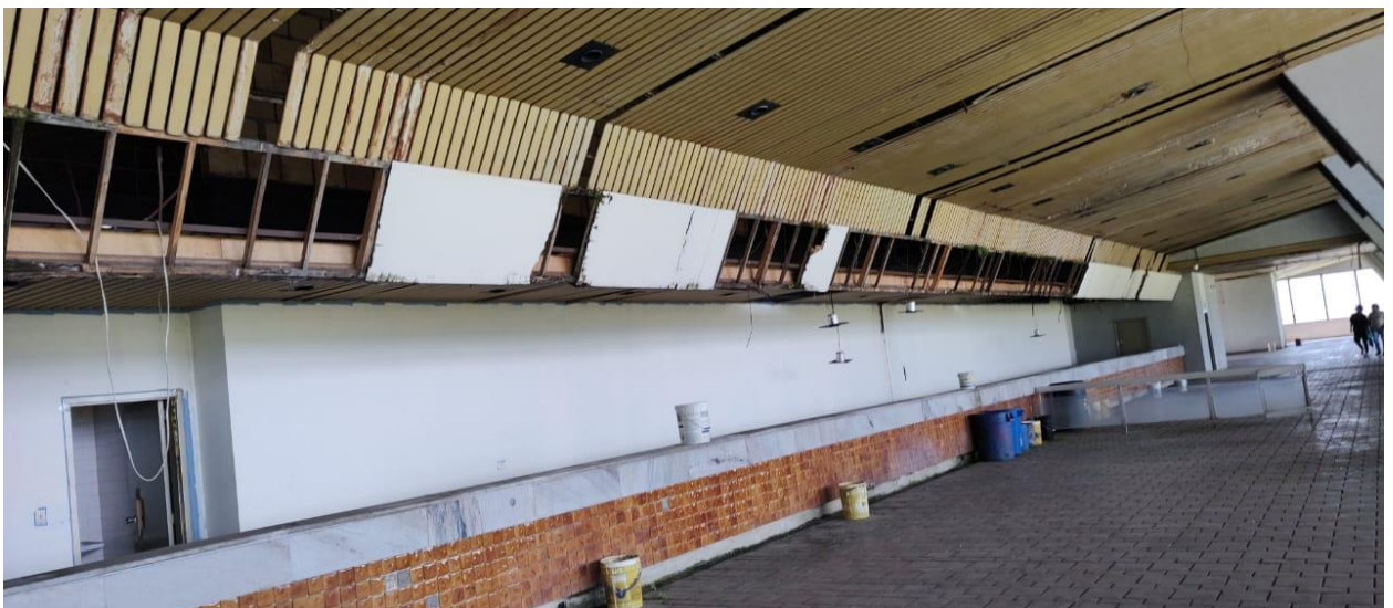
Figura 15. Imagen del Estado de la Edificación Existente para el año 2024
