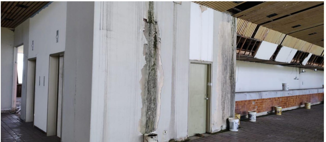
Figura 18. Imagen del Estado de la Edificación Existente para el año 2024
