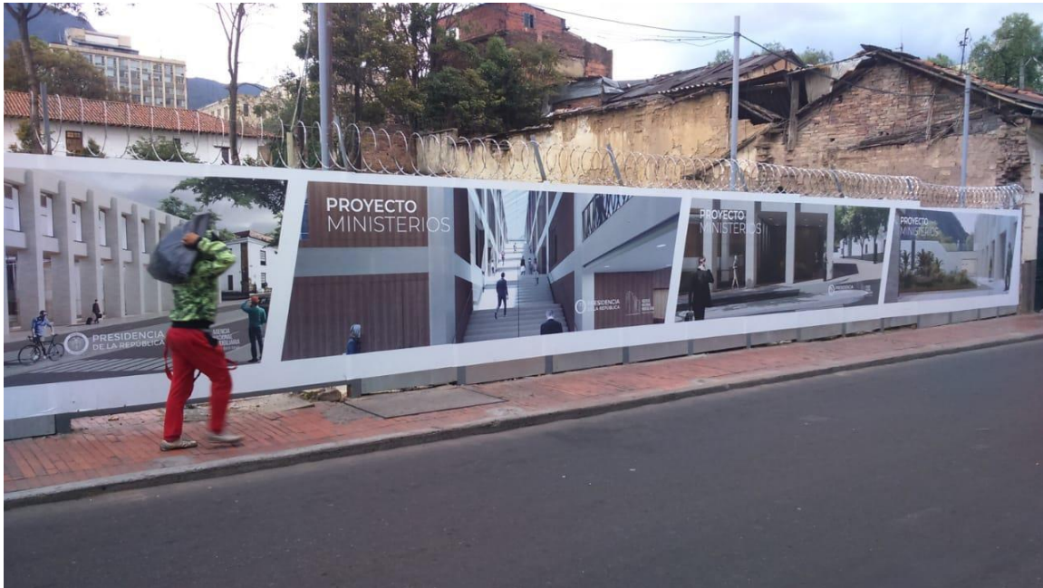
Figura 13. Predio donde actualmente se construye la manzana 10 del proyecto Ministerios
