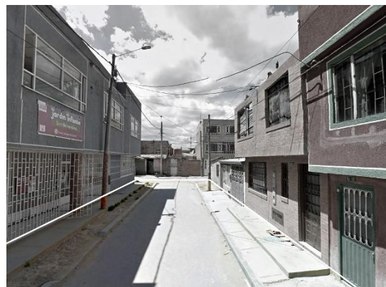
Fotografía 2: Estado físico Bueno
