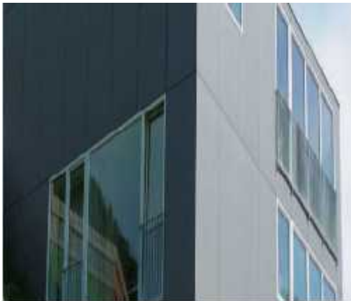
IMAGEN 10 Fachada All Face 1
