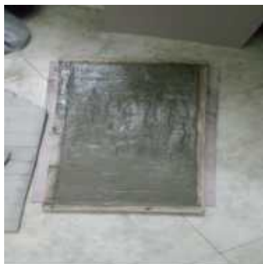
Fotografía 17 Fundida de concreto 3
