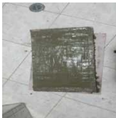
Fotografía 13 Fundida de concreto 1
