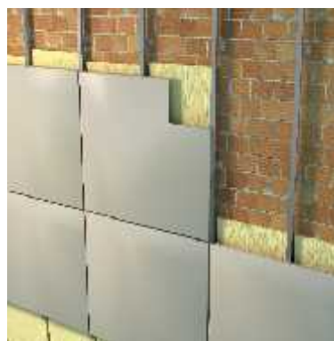
IMAGEN 1 Estructura Fachada Ventilada
