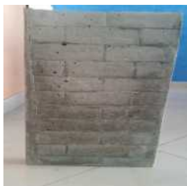
Fotografía 12 Acabado de molde
