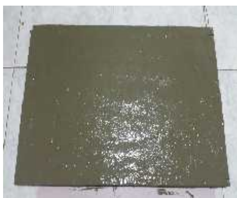
Fotografía 28 Fundida de concreto 4
