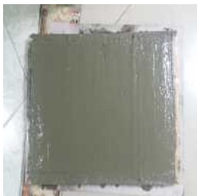
Fotografía 14 Fundida de concreto 2
