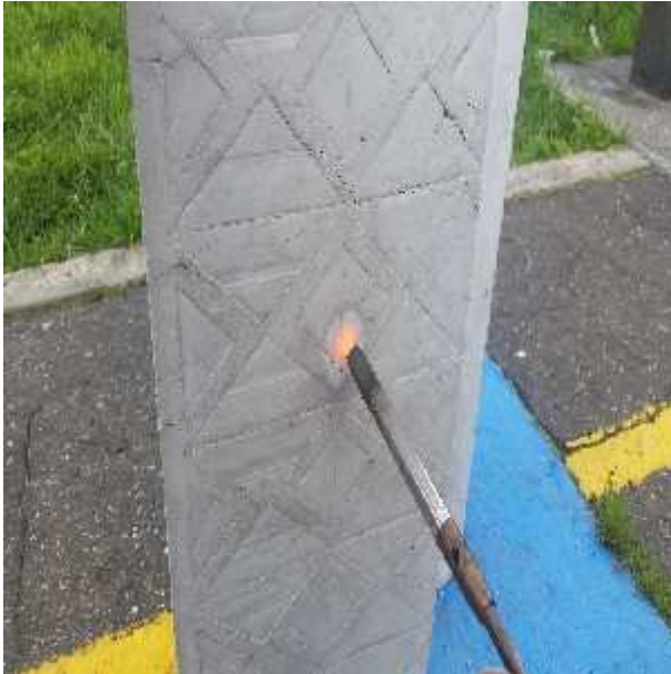
Fotografía 47 Efecto del fuego en el prefabricado
