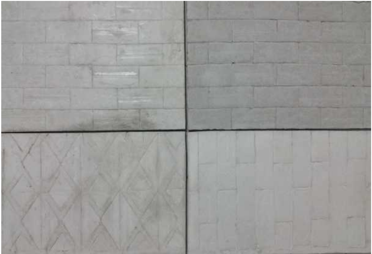
Fotografía 32 Acabados de Prefabricados
