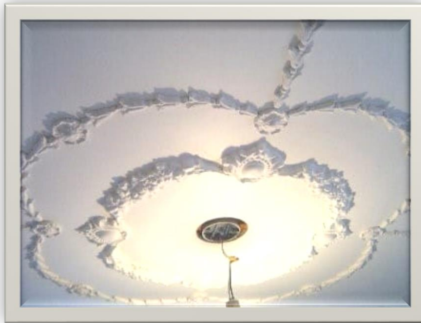
Figura 3. Cielo raso de yeso plaster.
