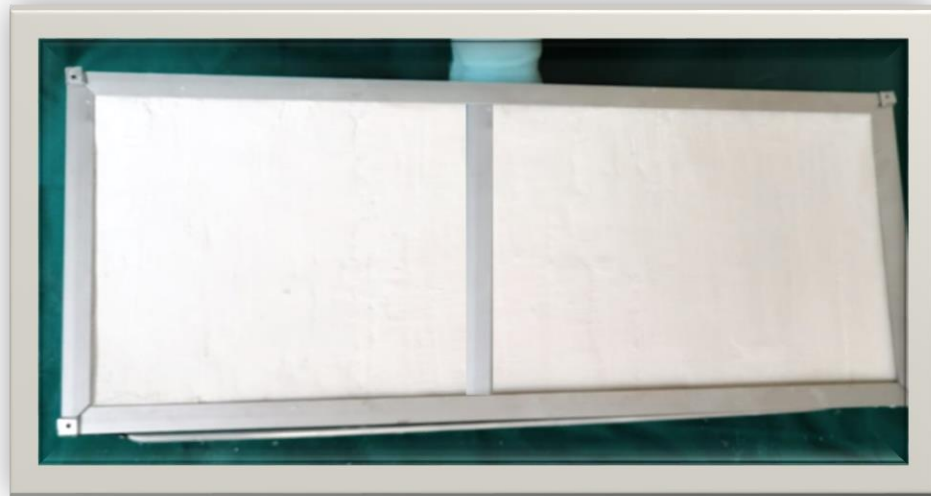
Figura 38. Estructura metalica de cielo raso panel final
