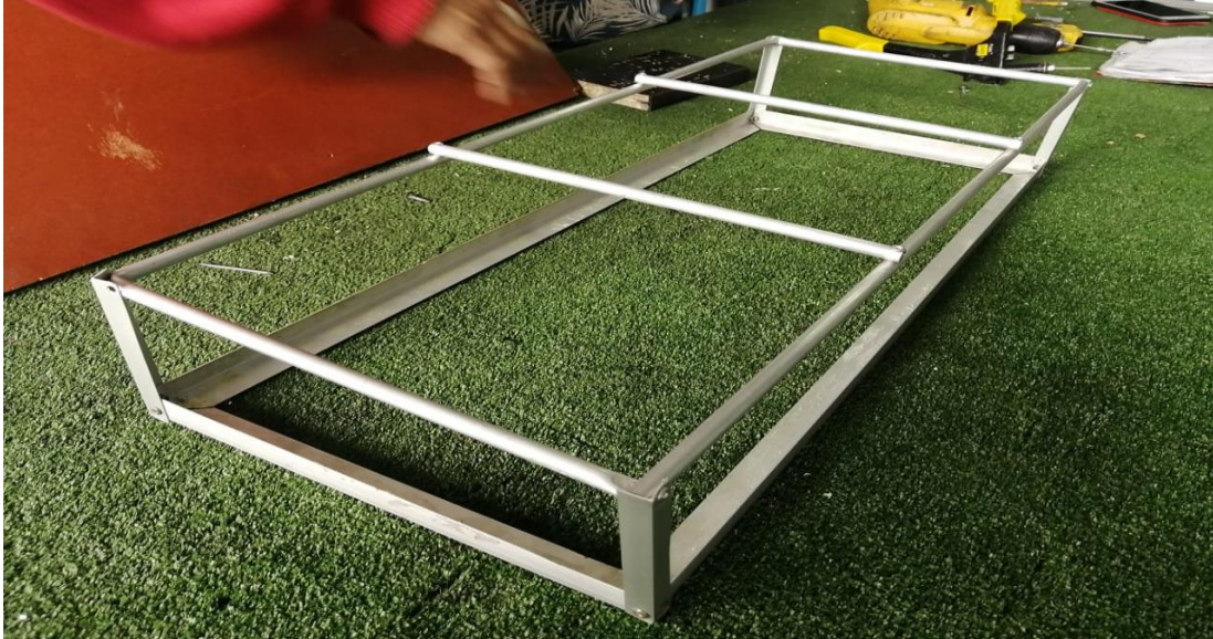
Figura 37. Estructura metalica de cielo raso de 24x60 cm y de 1 cm de anchura
