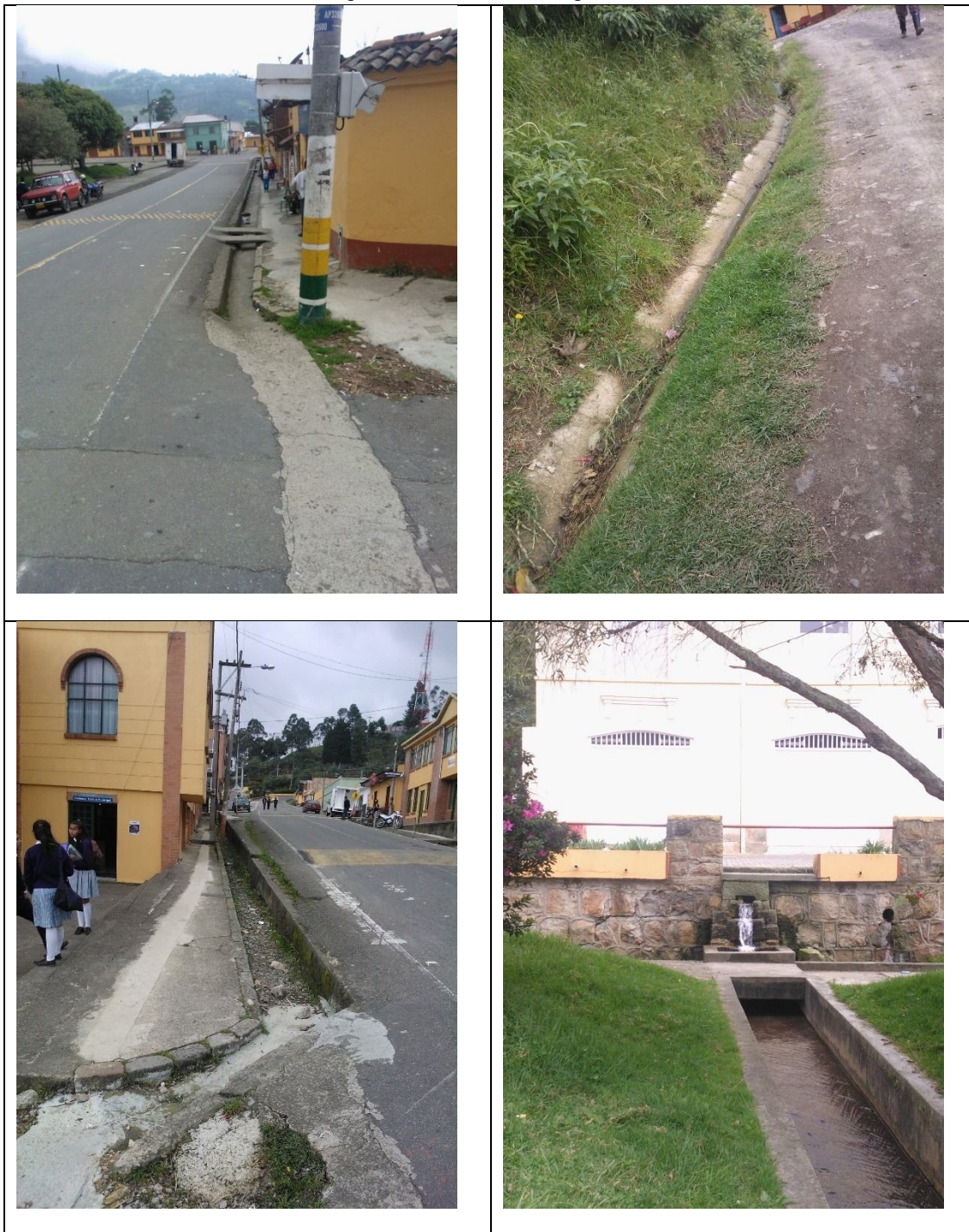
Figura 12. Cunetas de aguas lluvias.
