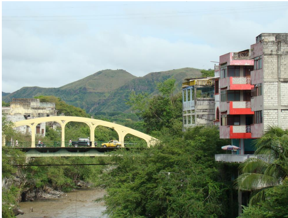
Imagen 01: Deterioro de Infraestructura Colindante al Rio.
