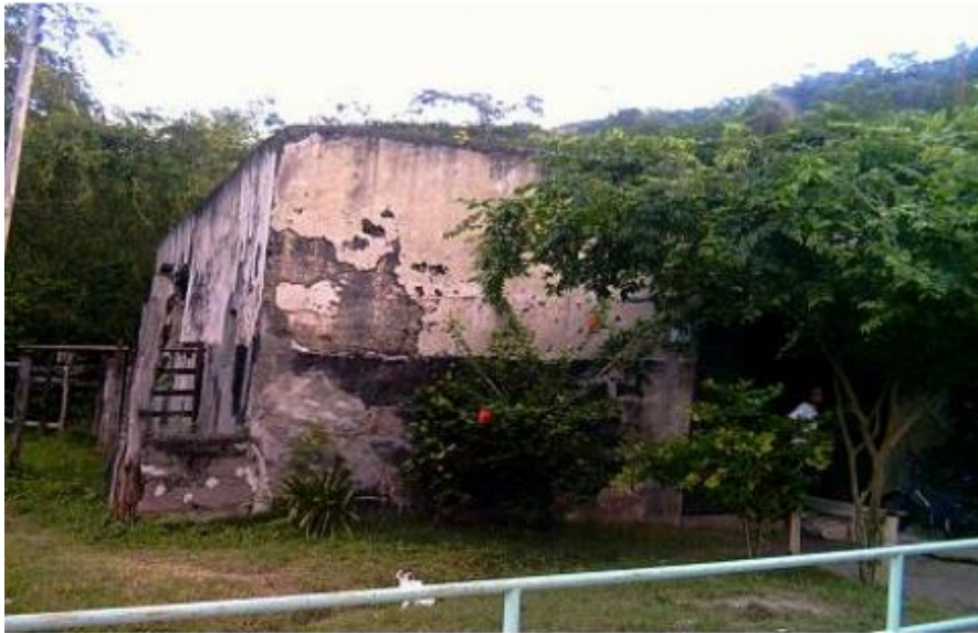
Imagen 07: Antigua Bodega, en el Puerto Arranca plumas.
