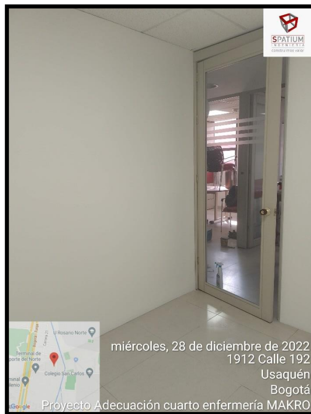
Ilustración 3. Seguimiento obra Adecuación enfermería Makro. Fuente: Autor
