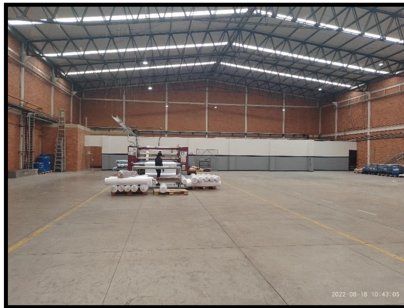
Figura 1. Seguimiento Mezanine Bodega KOAJ. Fuente: Autor
