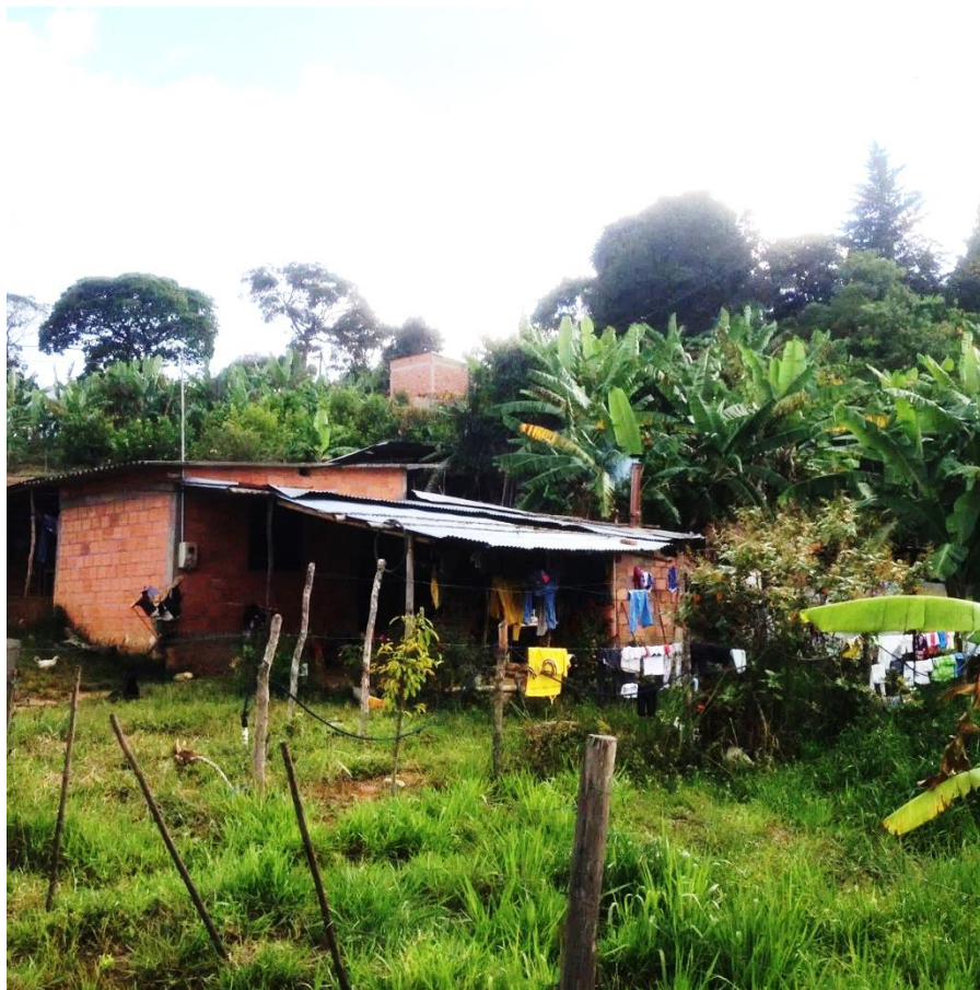
Figura 13. Vivienda tipo de sectores vulnerables de Bochalema. Fuente propia.
