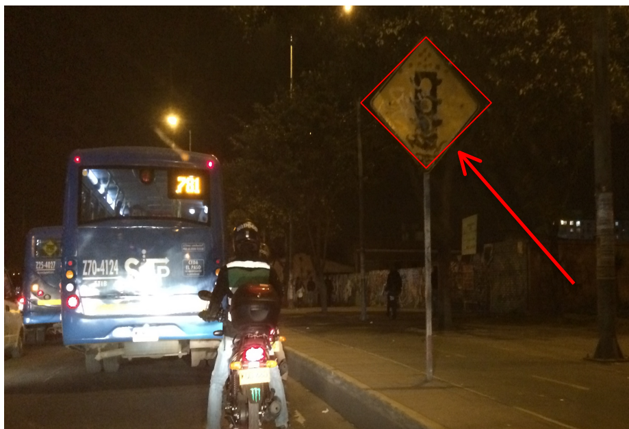
Imagen 43. Señal poco visible y legible en condiciones de noche
