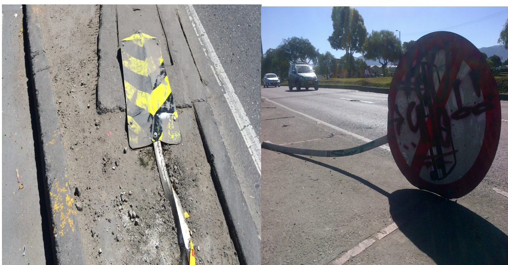
Imagen 35. Señales de tránsito en mal estado
