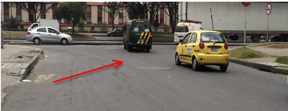
Imagen 24. Falta de señalización horizontal. Calle 4
