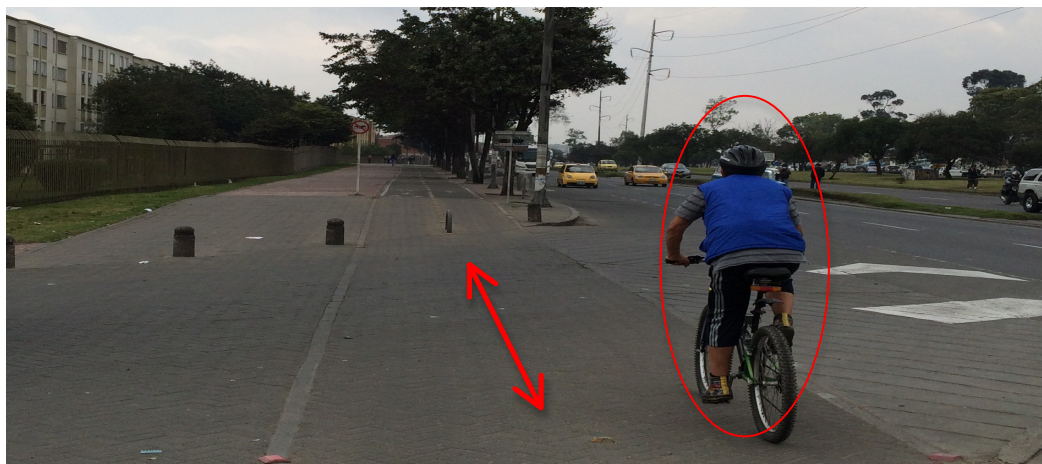
Imagen 71. Ciclorruta paralela y segregada al corredor de la Av. Boyacá
