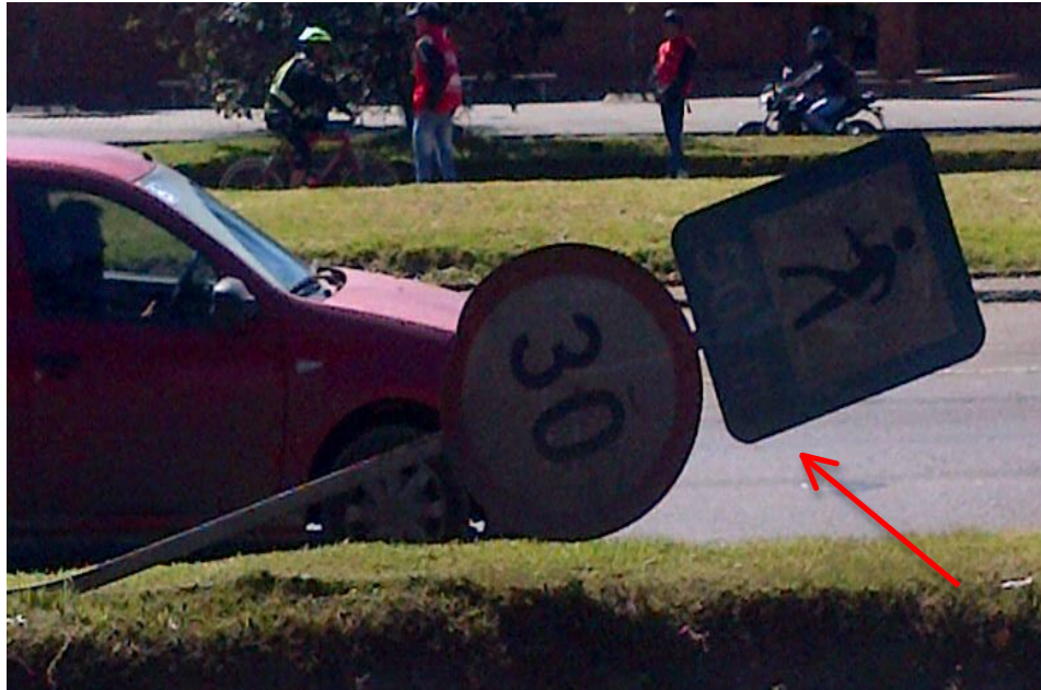
Imagen 36. Señal caída y en mal estado
