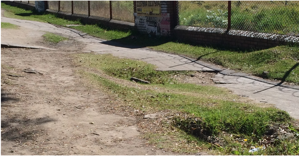
Imagen 67. Anden con discontinuidades Bavaria
