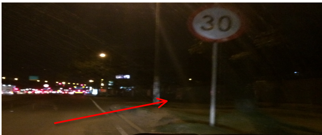
Imagen 88. Iluminación y andenes inicio de Bavaria con Av. Boyacá
