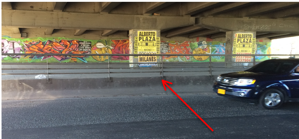
Imagen 68. Barreras metálicas. Av. Boyacá con Cale 13
