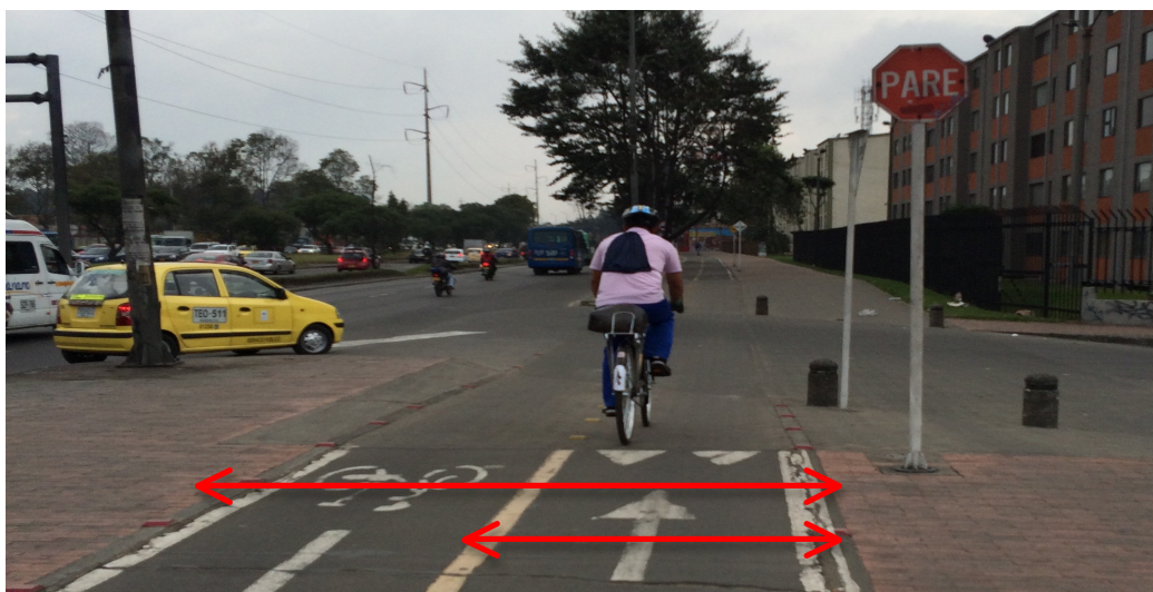
Imagen 73. Sección uniforme y constante de ciclorruta. Av. Boyacá con calle 11 A
