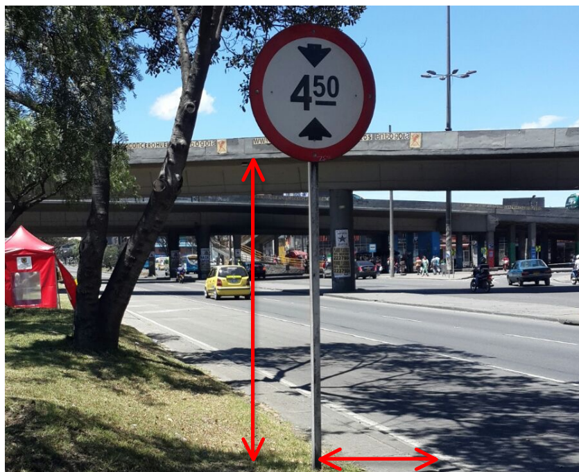
Imagen 41. Altura y distancia de tablero a la vía. Av. Boyacá con Primero de Mayo
