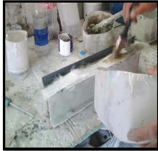
Imagen Número Ocho: Aplicación Fibra Sobre el molde en MDF.
