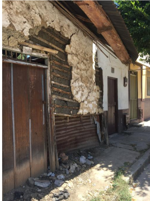
Trabajo de campo, Fotografía Propia
