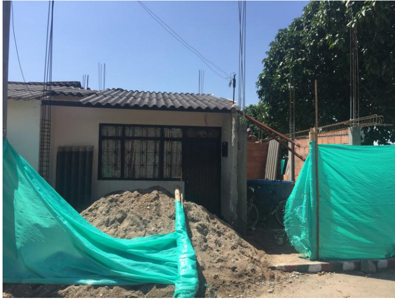
Trabajo de campo, Fotografía Propia
