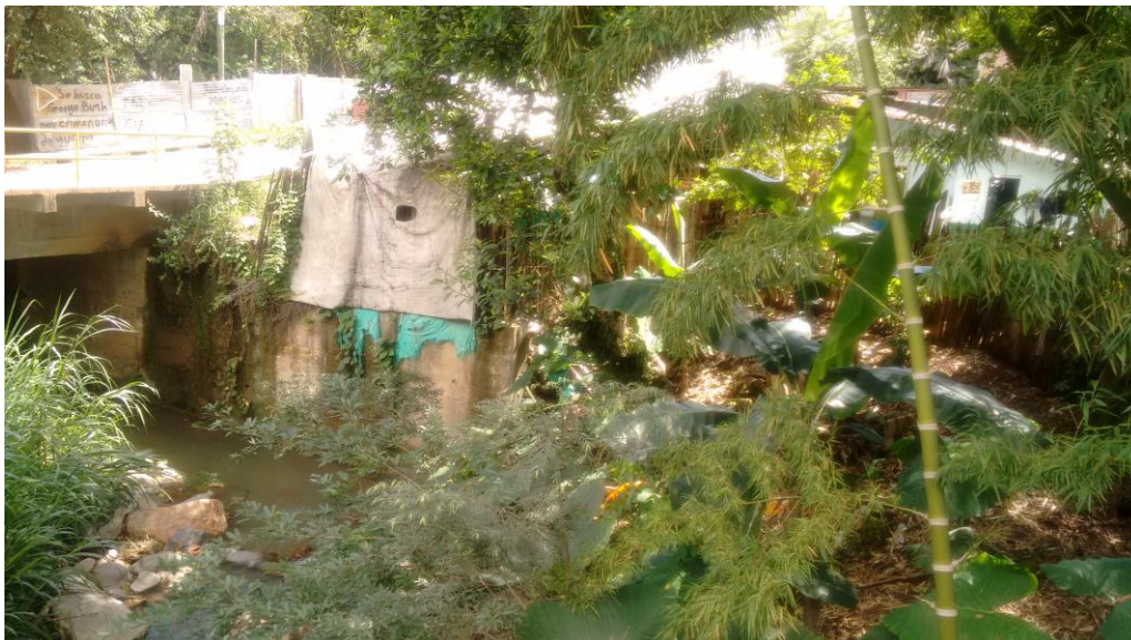
Trabajo de campo, Fotografía Propia
