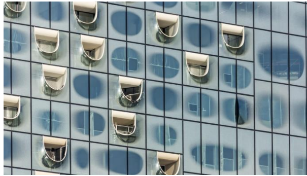
Imagen 24. Material en fachada
