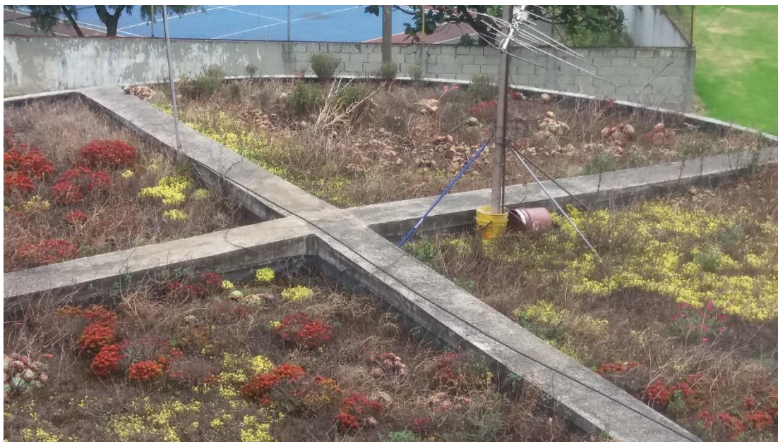
Imagen 2. Cubierta verde Edificio Uriel Gutiérrez
