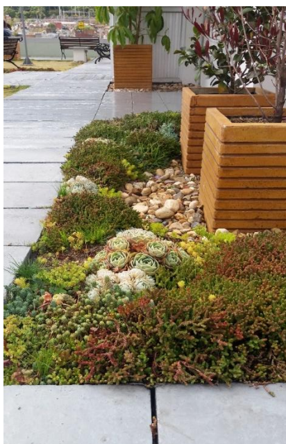
Imagen 1. Cubierta verde transitable de la Biblioteca de la Universidad La Gran Colombia
