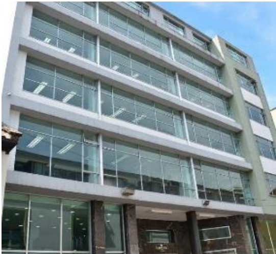
Imagen 4. Fachada exterior del edificio
