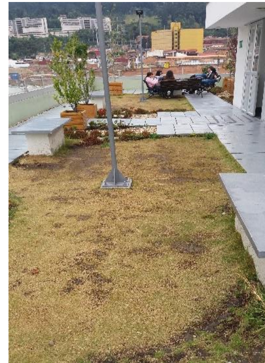
Imagen 6. Cubierta verde extensiva del edificio II
