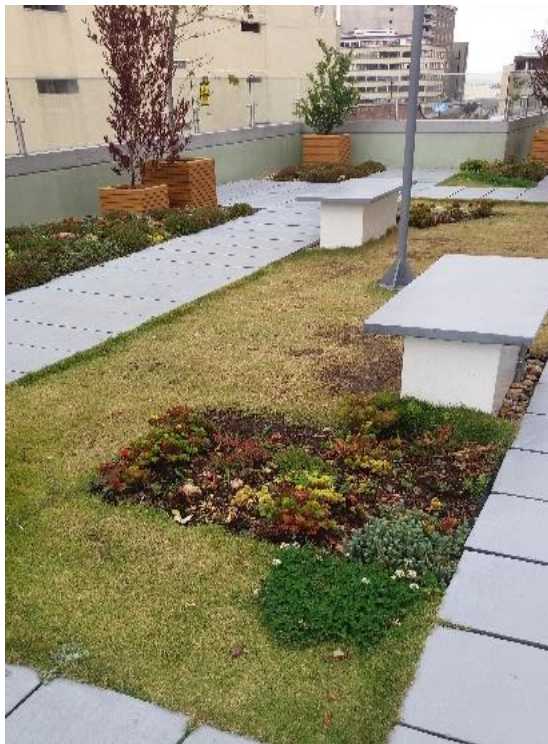
Imagen 7. Cubierta verde extensiva del edificio
