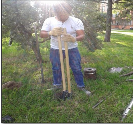
Ilustración 28. Descapote y retiro de relleno del material presente en el punto escogido para el sondeo de exploración.
